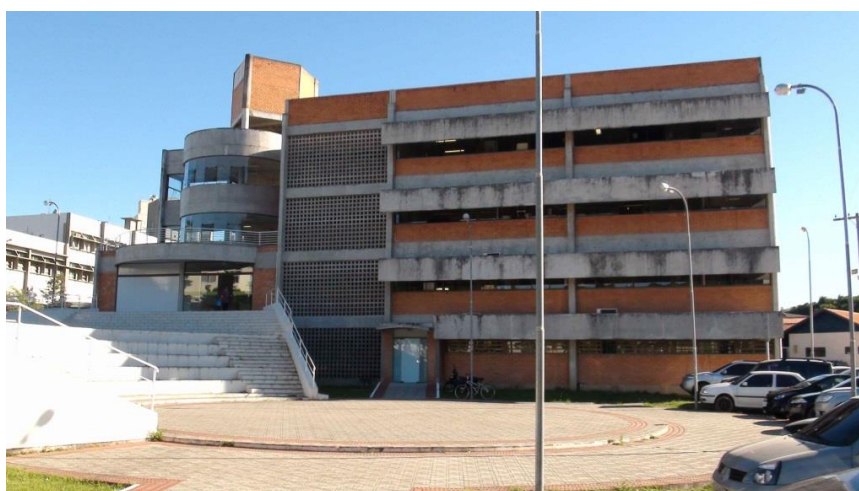
Fig.5 – Fachada do prédio onde se encontra o Lasipo
