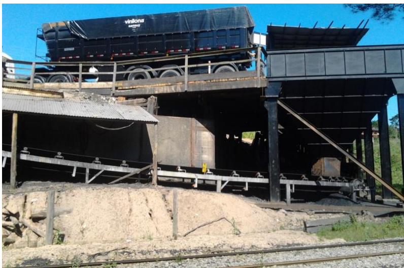
Imagem 5 Descarregamento rodoviário de carvão
