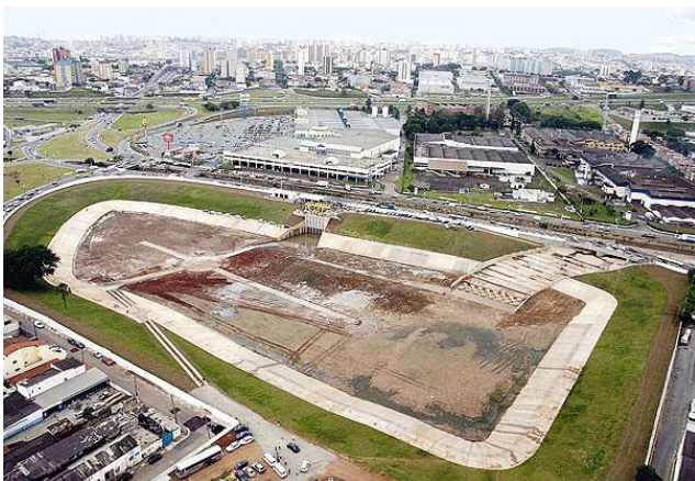
Figura 36 - Piscinão da Vila Pauliceia, em São Bernardo (SP), com capacidade para absorver 380 milhões de litros de água
