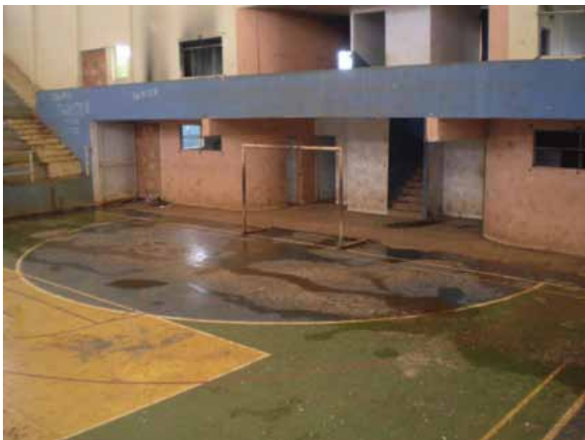
Figura 12 – Ginásio Municipal Poliesportivo João Barbosa, Guapé-MG, 2010.
