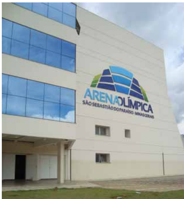
Figura 16 - Arena Olímpica, São Sebastião do Paraíso-MG, 2010
