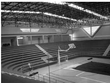
Figura 35 - Ginásio, São José da Barra – MG, 2010.
