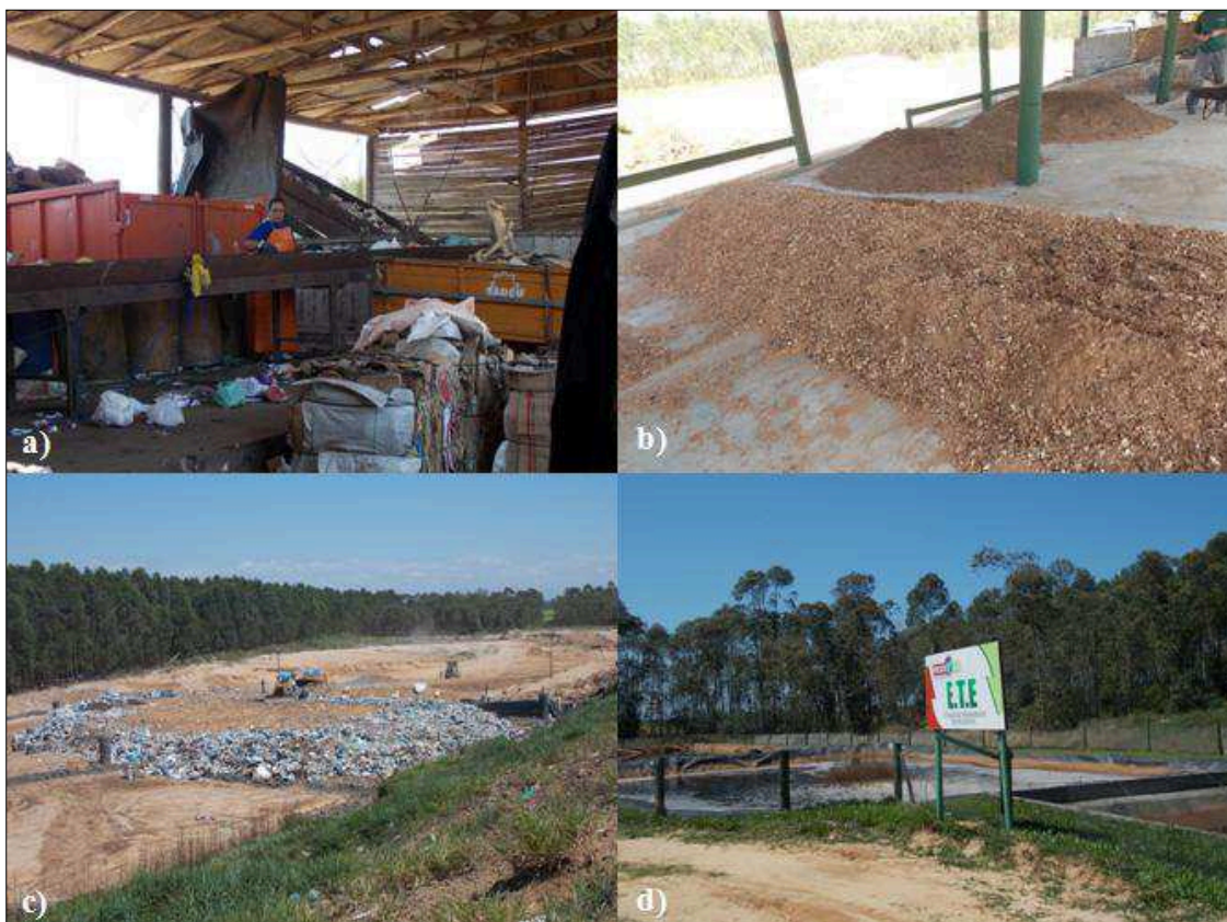
Figura 3.2 – Sistema atual de gerenciamento dos RSU no aterro Preservale: a) Triagem, b) Compostagem, c) Disposição dos resíduos no solo impermeabilizado e d) Tratamento dos efluentes
