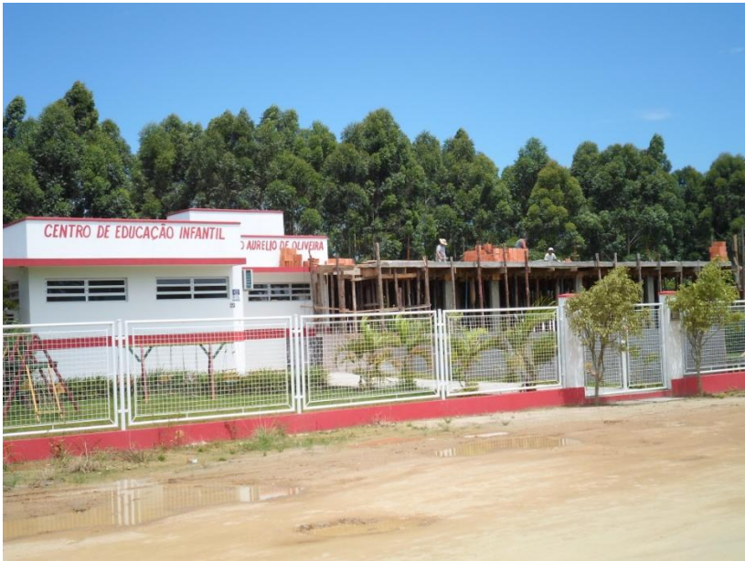
Figura 21 - Creche ( e obras de ampliação) no Jardim Progresso – dez./2013. Fonte: Acervo pessoal.
