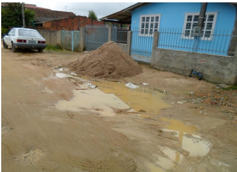
Figura 32 - Ausência de pavimentação no Jardim Progresso.
