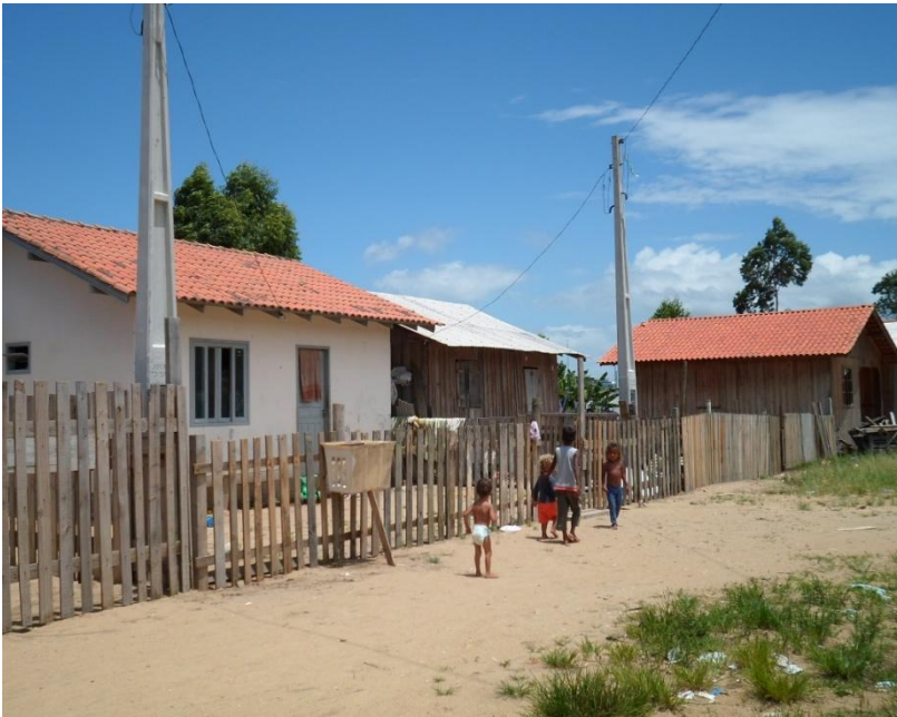
Figura 28 - Casas entregues em 2011 pela Prefeitura Municipal de Tijucas. Fonte: Acervo pessoal – jan./2014.
