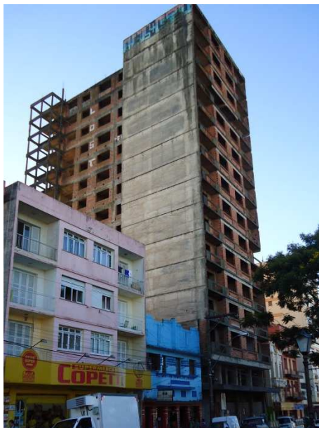
Figura 37: O “edifício-esqueleto” da Avenida Rio Branco. FONTE: a autora em 28/03/2012.
