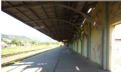
Figura 42: A plataforma da Estação Ferroviária. FONTE: a autora, em 12/10/2012.
