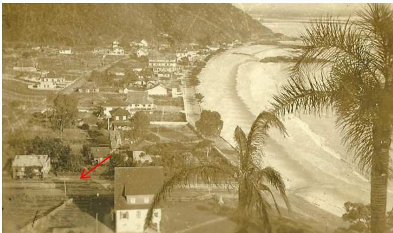
Figura 78 – Ribeirão após ser canalizado.
