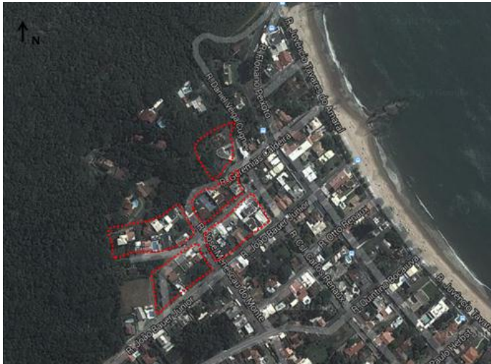
Figura 252 – Indicação das quadras que fazem parte do loteamento Vila Santa Ana, Cabeçadas.
