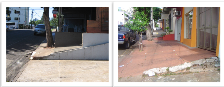
Figura 2: Calçadas Inadequadas e desprovida de normatização
