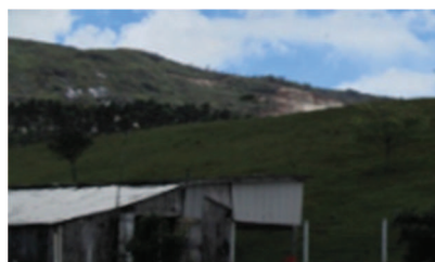
Parte posterior do empreendimento
