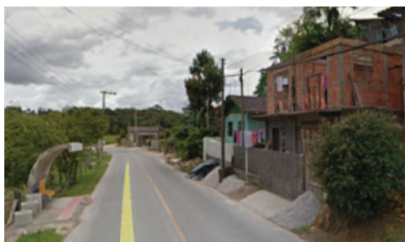
Conjunto de casas mais próximo.
