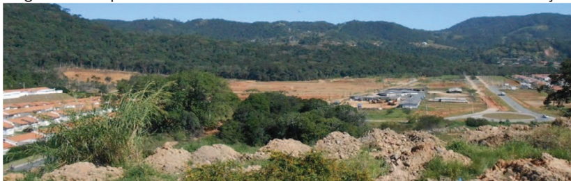
Vista geral da área em construção, na esquerda o C. H. Moradas de Palhoça.
