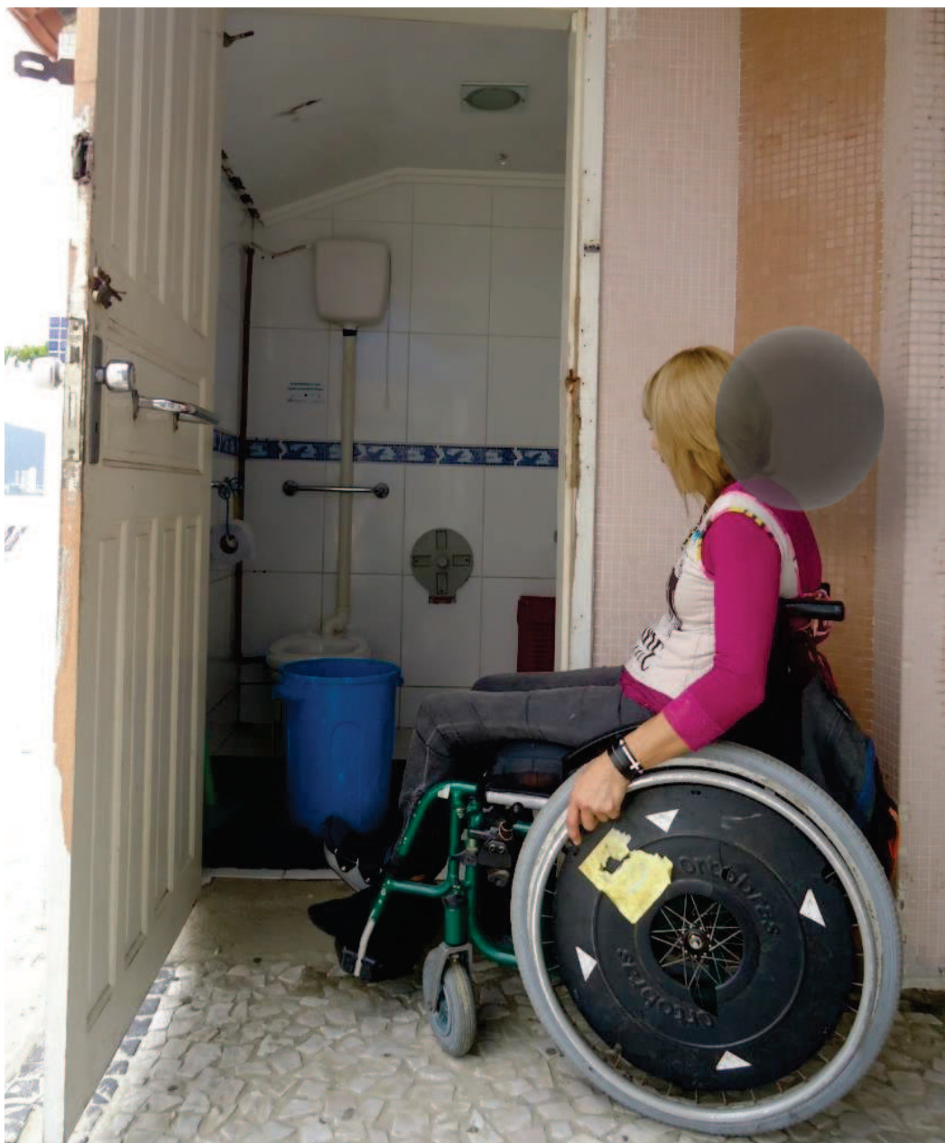
Imagem 66. Entrando no banheiro. Fonte: Acervo da autora,2014.
