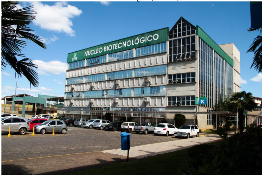
Figura 42 - Vista lateral do Núcleo Biotecnológico (bloco K)
