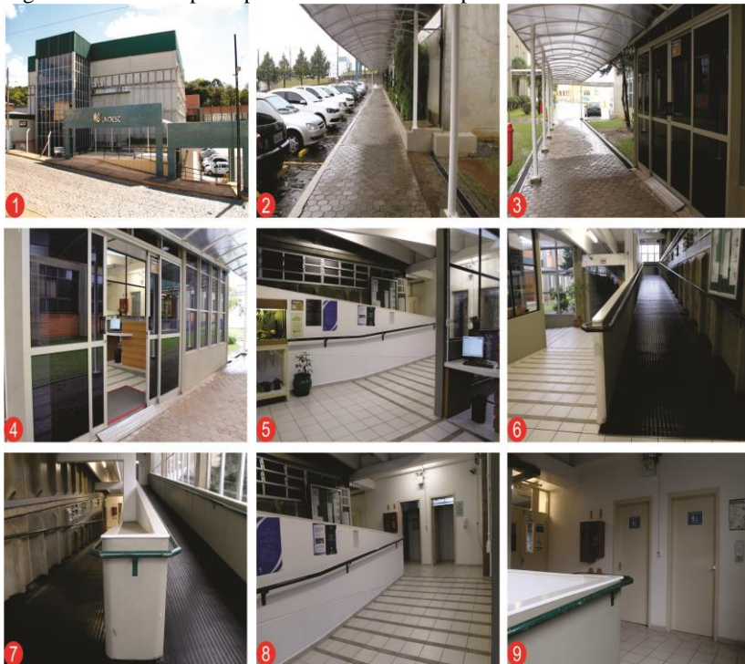
Figura 43 - Entrada principal do bloco K até o 1º piso.
