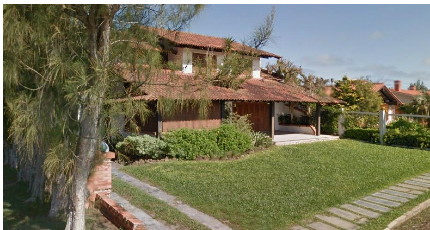
Figura 23 - Habitação unifamiliar com frente aberta e isolada no lote
