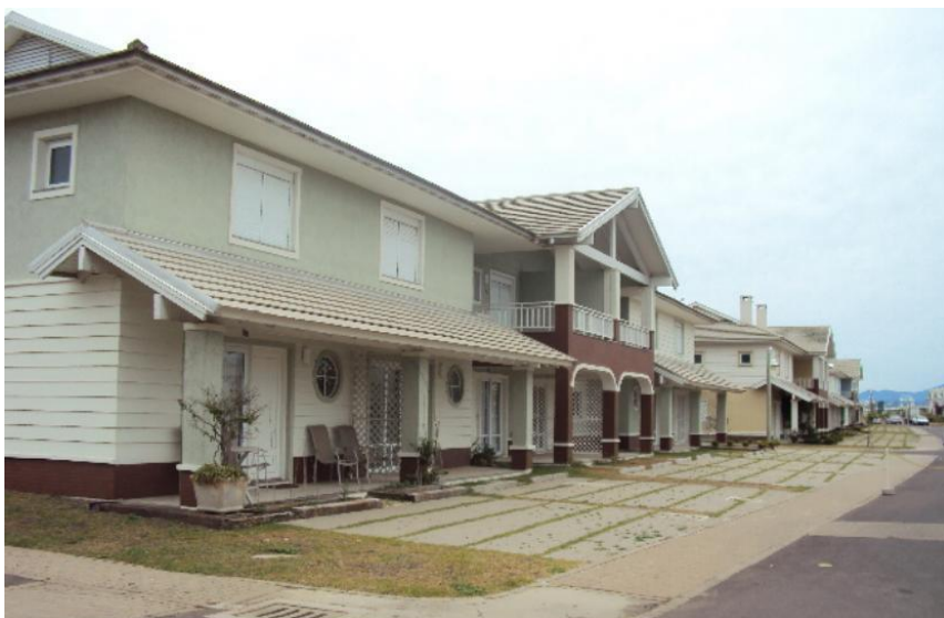
Figura 28 - Condomínio horizontal Pacific, com habitações em fita
