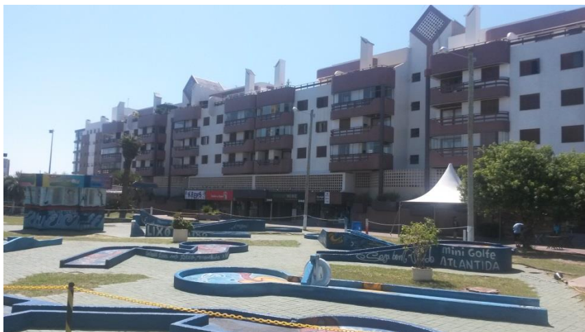
Figura 26 - Edifício multifamiliar de seis pavimentos com térreo comercial
