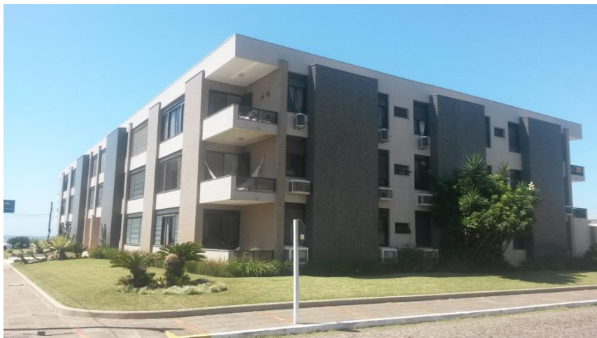
Figura 24 - Edifício multifamiliar de três pavimentos
