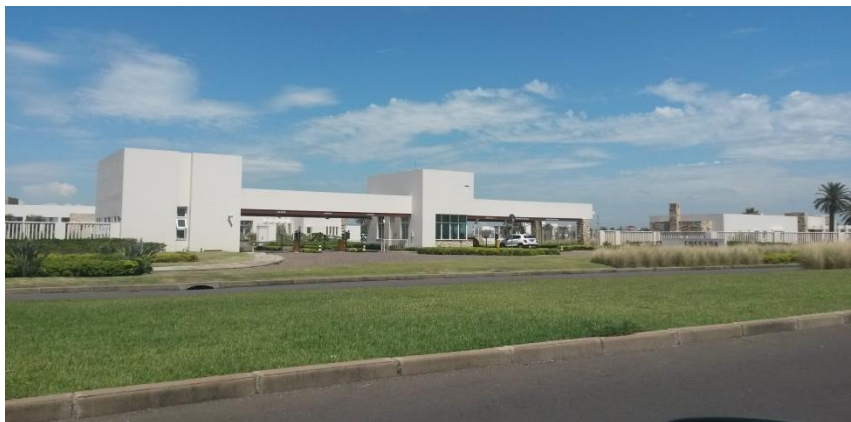
Figura 32 - Pórtico de Entrada do Condomínio Enseadas Xangri-Lá
