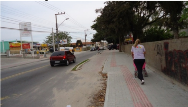
Figura 65 – Material solto na rodovia
