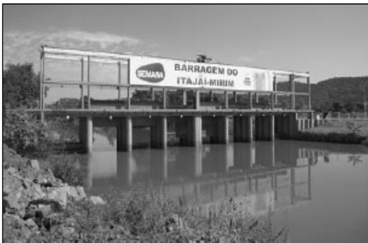
Figura 112 - Barragem do SEMASA.
