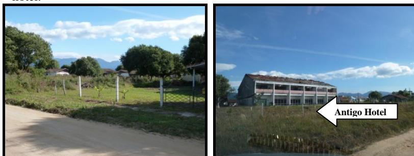
Figura 33 – Lotes que compõem a ZUTb, local de instalação de antigo hotel.
