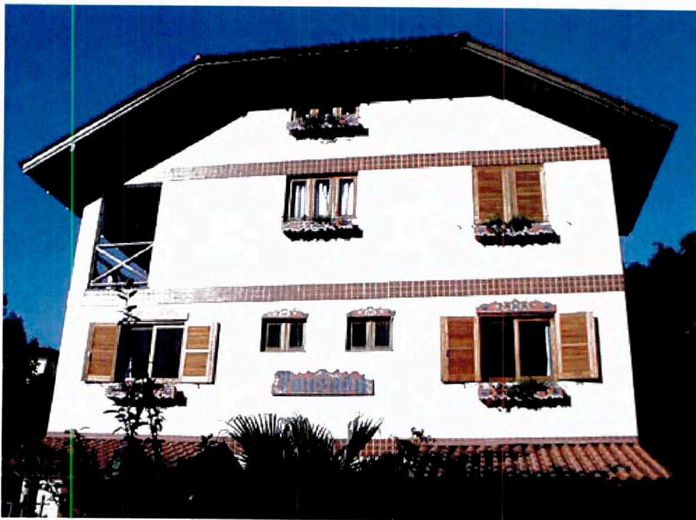
Foto 01: Primeiro bloco construído da pousada, 12 unidades habitacionais.
