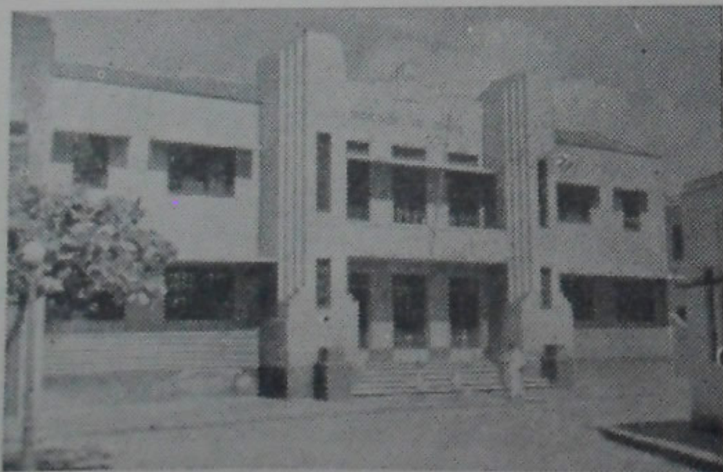
MACEIÓ, Alagoas — Faculdade de Direito, na praça Bráulio Cavalcanti
