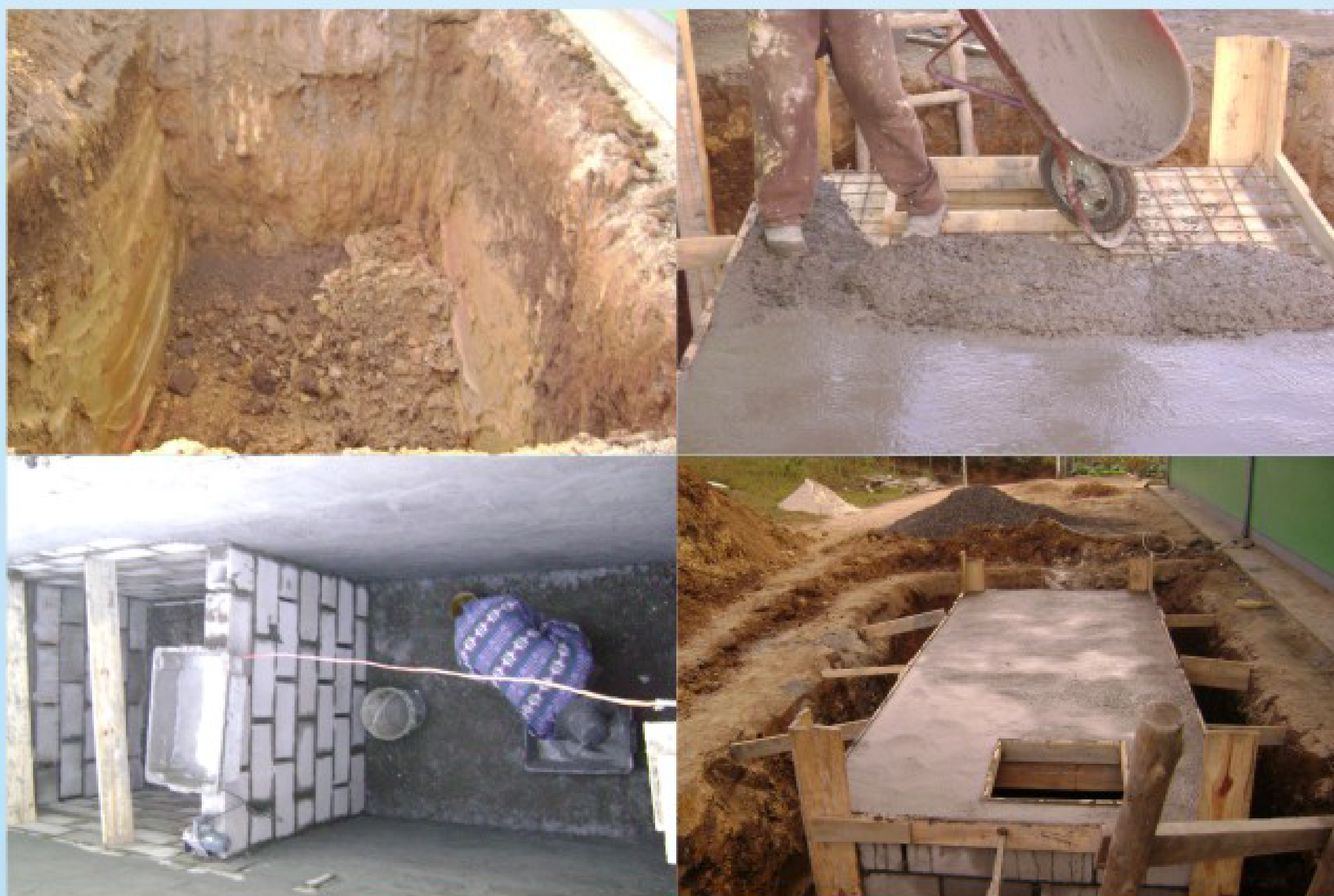
Figura 3 - Sequência de fotos da construção da fossa séptica na Escola Leopoldo Hanoff
