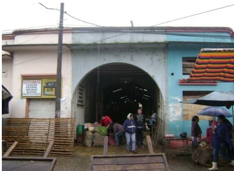
Imagem nº 13. Fachada do prédio da “Galería Municipal” de Timbío.
