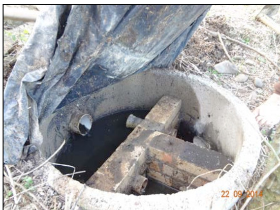
Imagens 5199 e 200 - Caixas de Inspeção do Sistema (entrada e saída).
