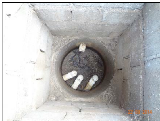
Imagens 5199 e 200 - Caixas de Inspeção do Sistema (entrada e saída).
