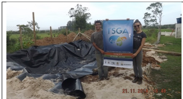
Imagem 20 - Finalização de etapa 1 para consolidação da cisterna.
