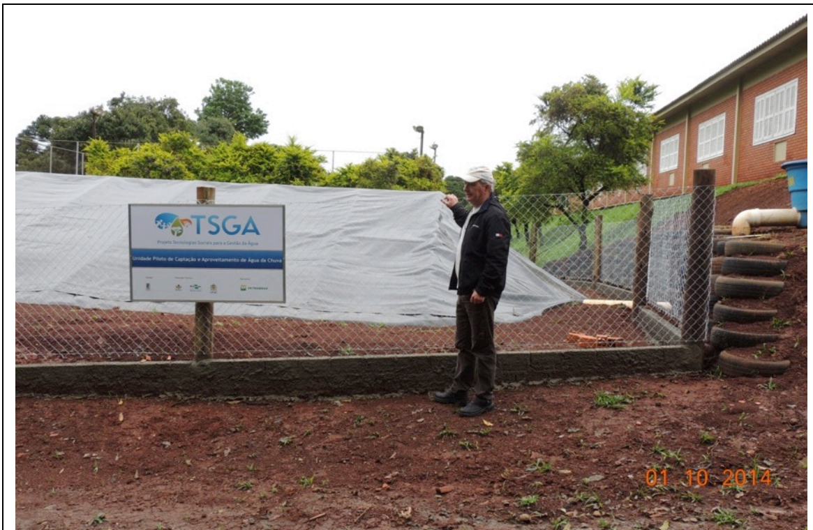
Imagem 16 - Cisterna do Centro de Treinamento de Chapecó – CETREC - Epagri.
