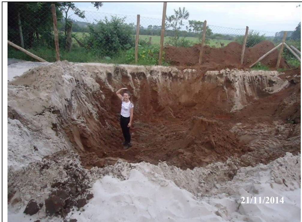
Imagem 19 - Cisterna antes da finalização da etapa 1.
