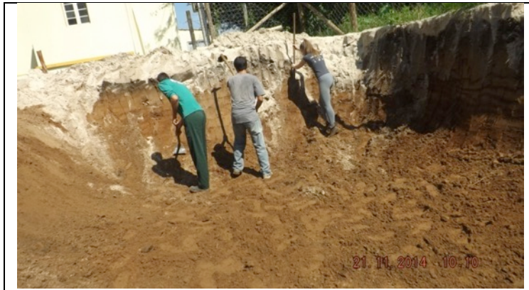
Imagem 18 - Continuação dos trabalhos de escavação.
