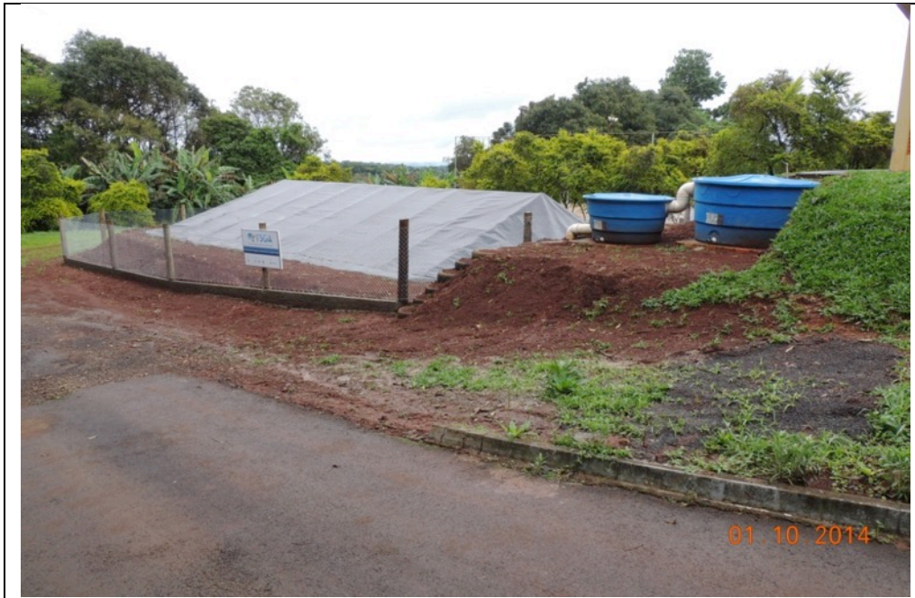
Imagem 15 - Cisterna do Centro de Treinamento de Chapecó – CETREC - Epagri.
