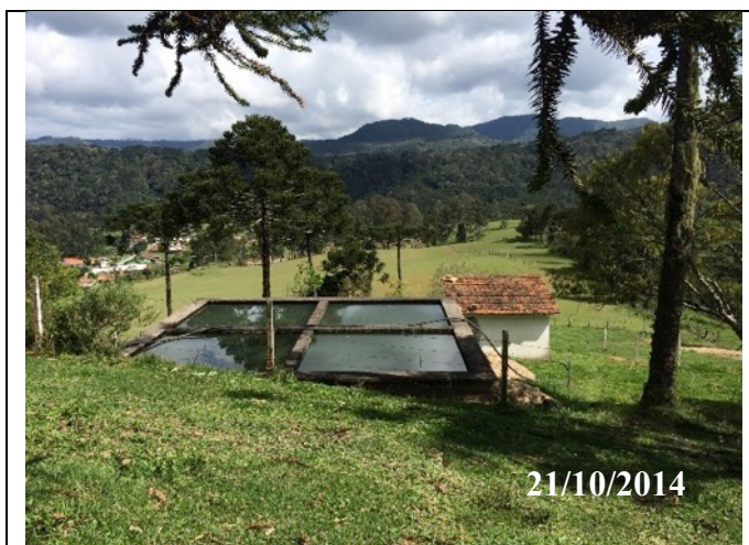
Imagem 27 - Reservatório e casa de química.
