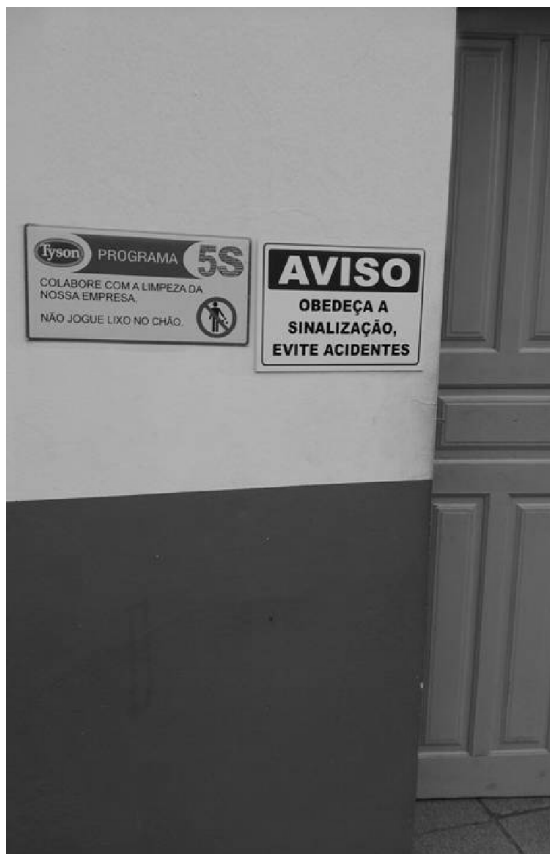
Figura 20: Banheiro masculino. (Antes) Fonte: Arquivo pessoal do autor. 2014
