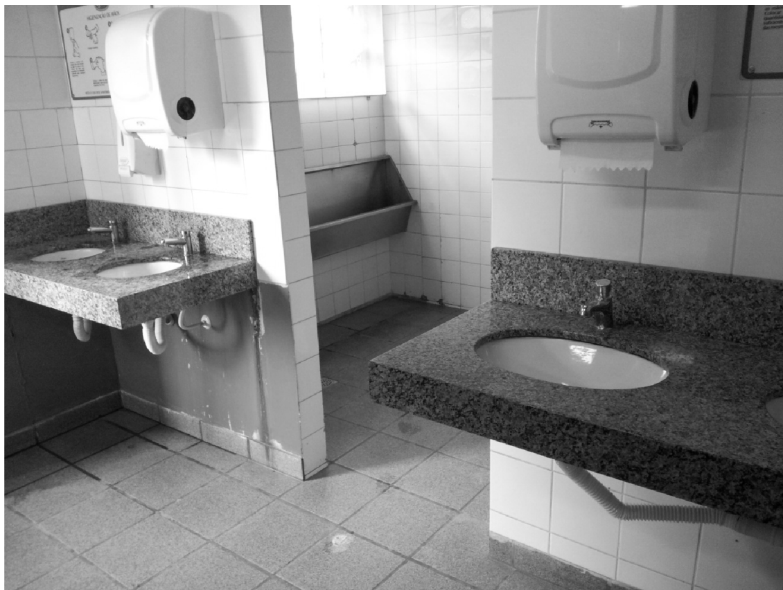
Figura 22: Instalação da segunda pia. (Depois)
