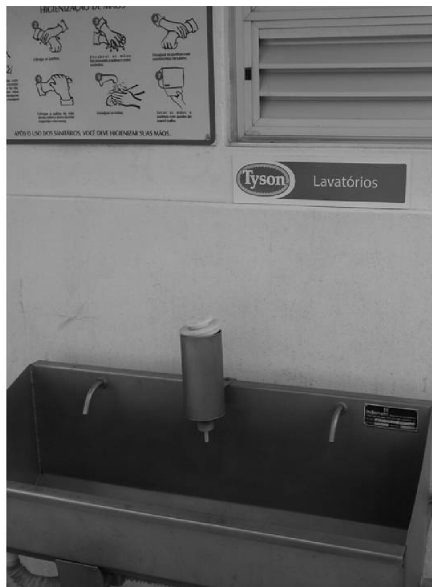
Figura 19: Identificação do lavatório externo. (Depois) Fonte: Arquivo pessoal do autor. 2014
