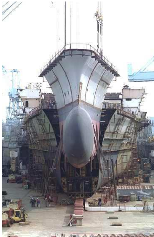
Figura 2: Junção de bloco ao restante da embarcação
