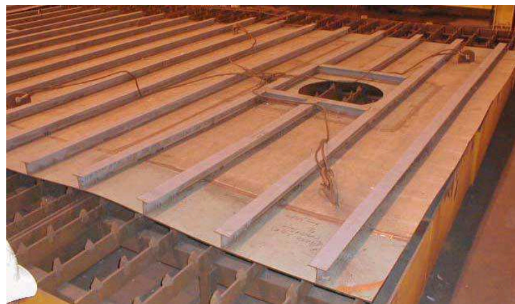
Figura 5: Distorção causada pelo processo de soldagem
