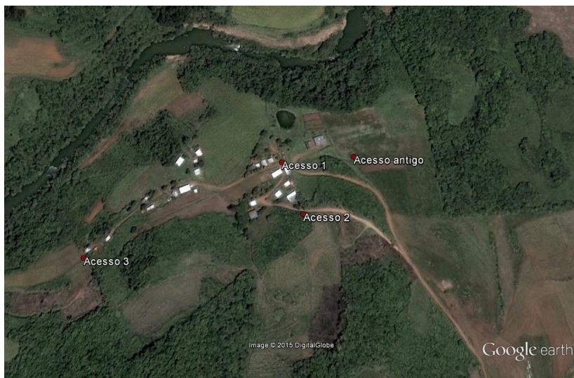
Figura 11 - Imagem aérea dos acessos (Fonte: Google Earth)
