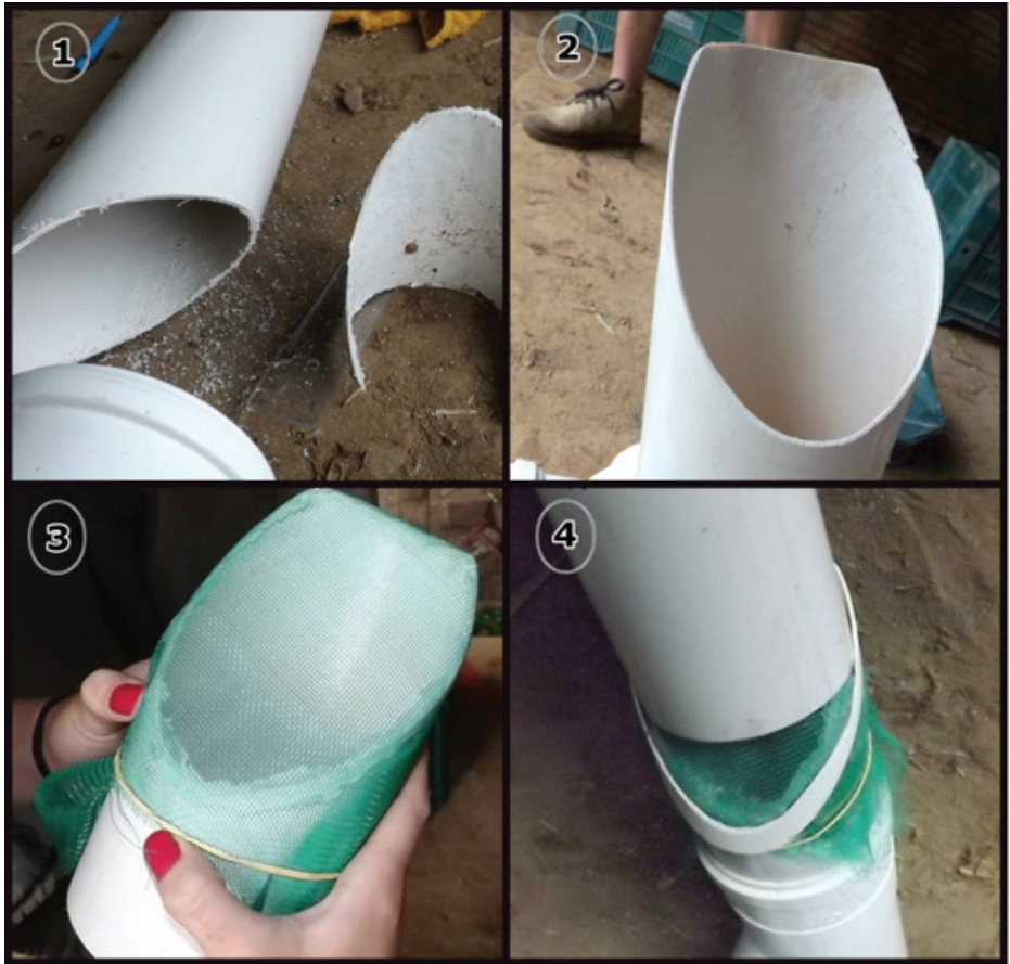
Figura 3: Confeção do filtro de sólidos. 1 - recorte do tubo PVC em 45°. 2 - peça maior a ser encaixada na tubulação. 3 - colocação da tela na peça maior. 4 - junção da peça maior no restante da tubulação e colagem da peça menor para um melhor acabamento.
