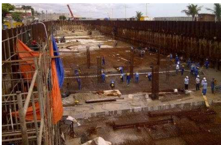
Figura 11: Preparação da laje de subpressão.
