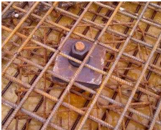
Figura 12: Aplicação dos tirantes na laje de subpressão.
