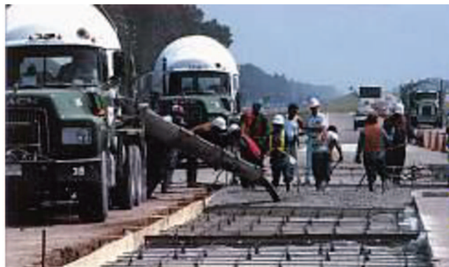
Figura 5 - Aplicação do cimento geopolimérico no aeroporto da Arábia Saudita.
