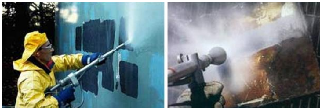
Figura 32 - Limpeza com jato abrasivo
