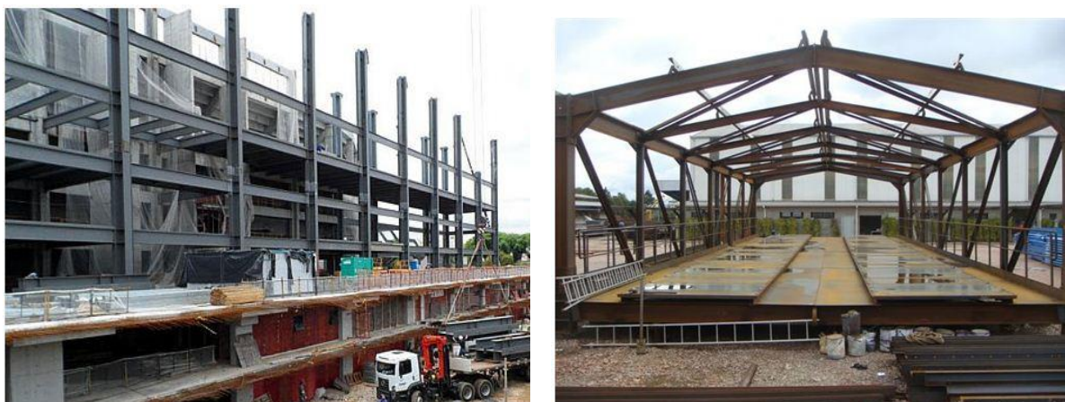
Figura 12 - Estruturas metálicas de edifício
