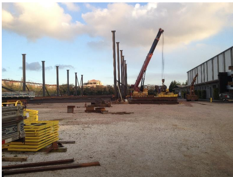
Figura 31 - Pré-montagem de fábrica
