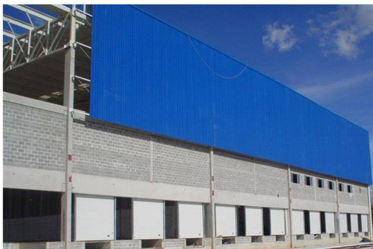
Figura 24 - Chapas de cobertura e fechamento
