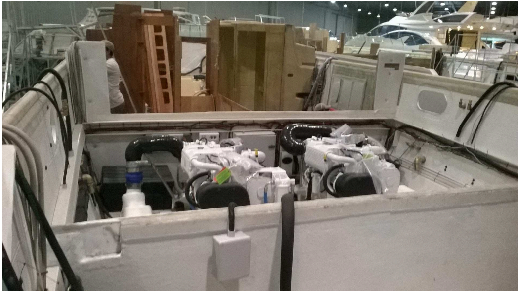
Figura 4. Montagem em casco aberto
