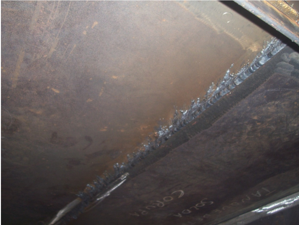
Figura 38 Junta após ser goivada, ainda sem acabamento de esmeril
