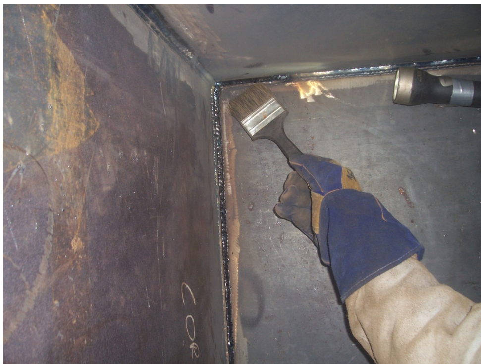
Figura 53 Preparação da junta em locais restritos a lixadeira
