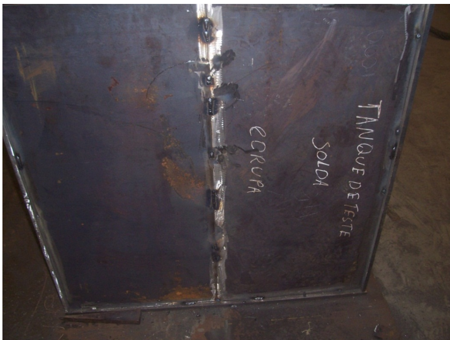
Figura 36 Travamento das peças com pontos em locais acessíveis a lixadeira
