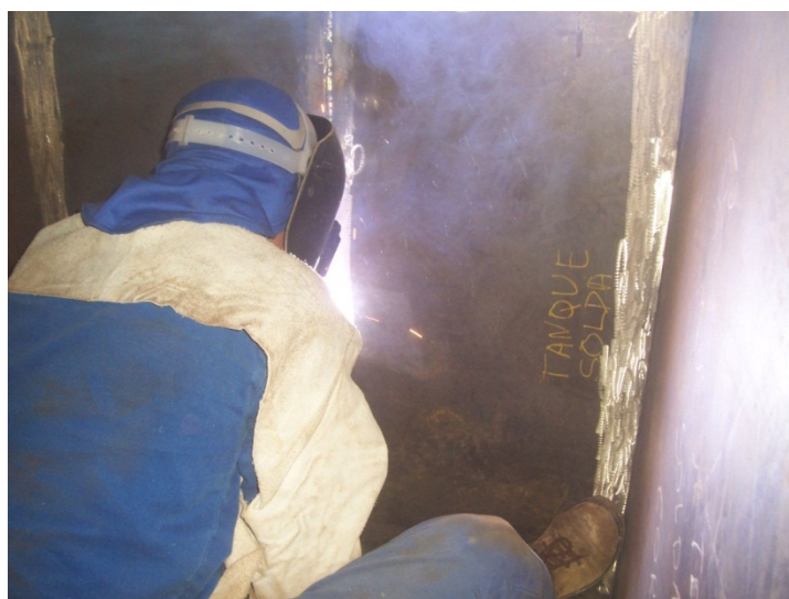
Figura 43 Soldagem vertical ascendente da junta de topo
