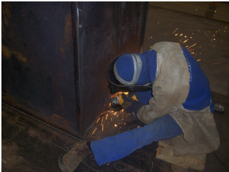
Figura 45 Preparação da junta
