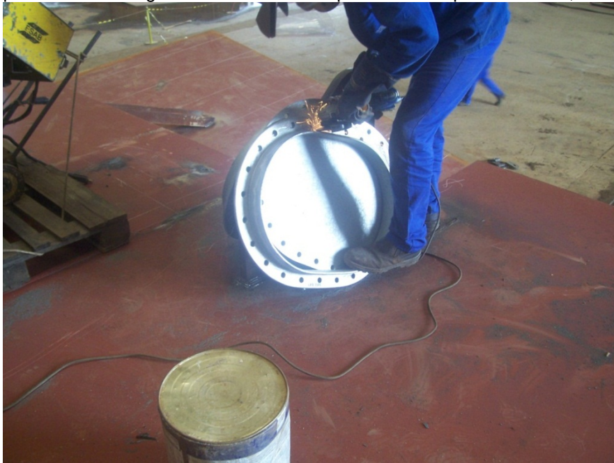
Figura 20 Limpeza da camada galvanizada nas áreas periféricas da porta de visita, onde será soldada
