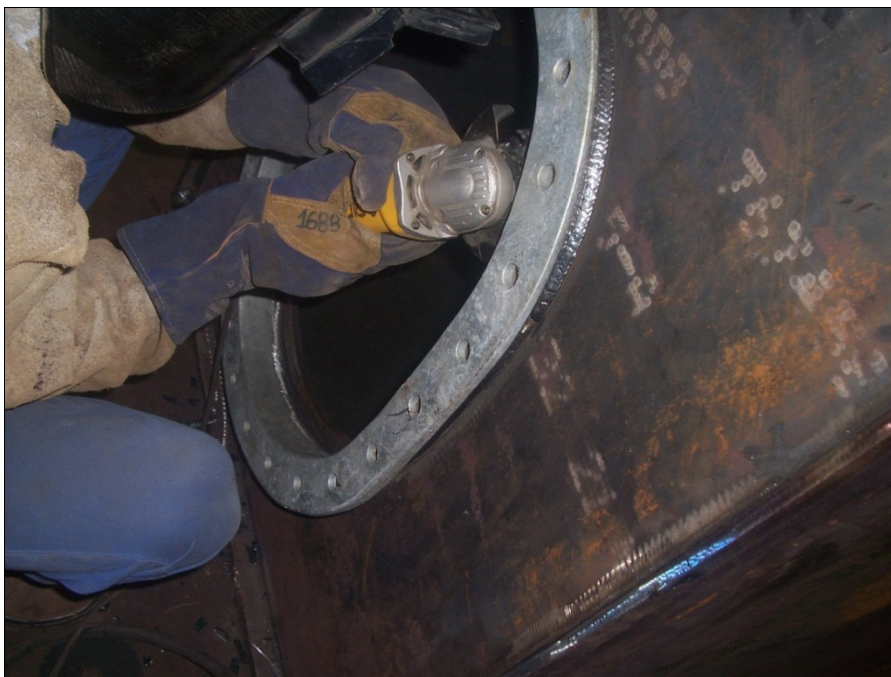
Figura 64 Remoção dos pontos de montagem no interior da porta após a soldagem externa
