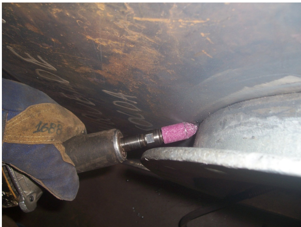
Figura 59 Acabamento nos locais de fechamento e abertura de arco
