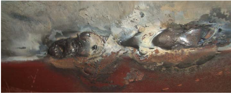
Figura 24 Ponto de fixação com poros e escória
