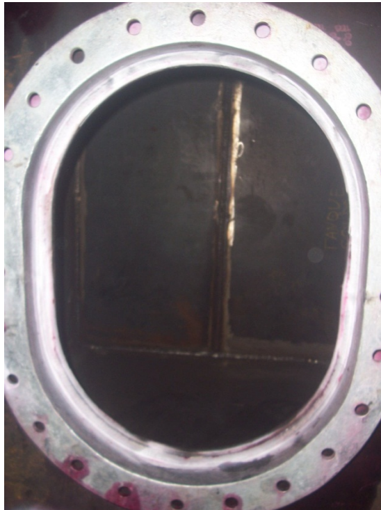
Figura 65 Inspeção de Líquido penetrante na solda da porta de visitas
