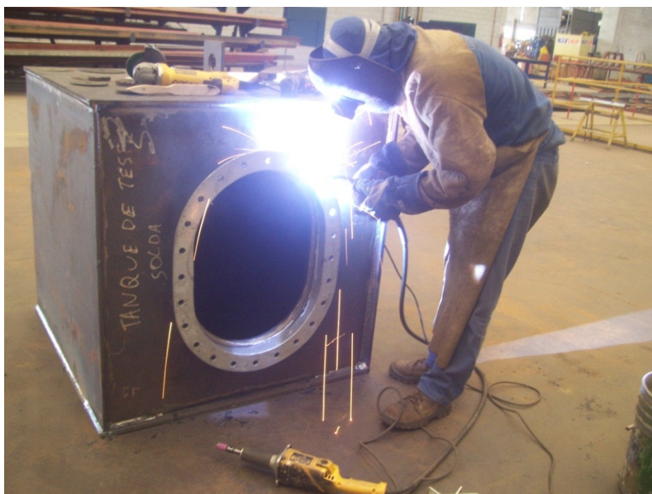
Figura 62 Soldagem na porta de visitas
