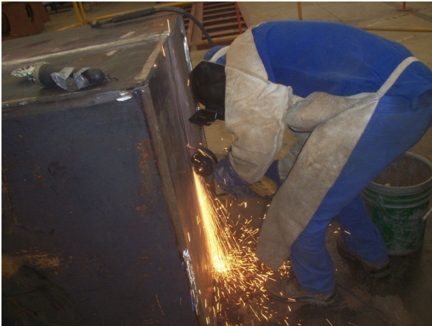
Figura 39 Acabamento e preparação da junta após a goivagem
