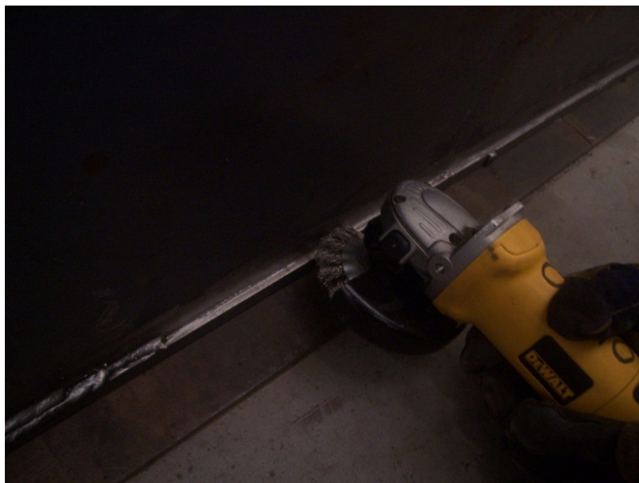
Figura 46 Limpeza da junta com escova rotativa, e passes com fechamento e abertura de arco em posições distintas
