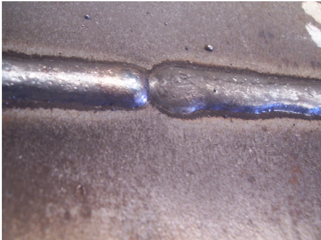
Figura 4 Deficiência na emenda dos cordões feita de forma exagerada, a fim de ilustrar a descontinuidade
