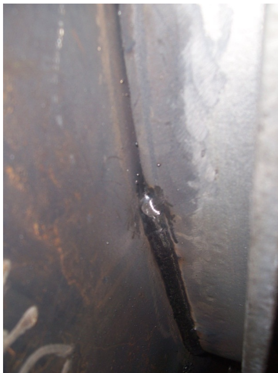
Figura 60 Unha de Acabamento feita com retífica na porta de visitas
