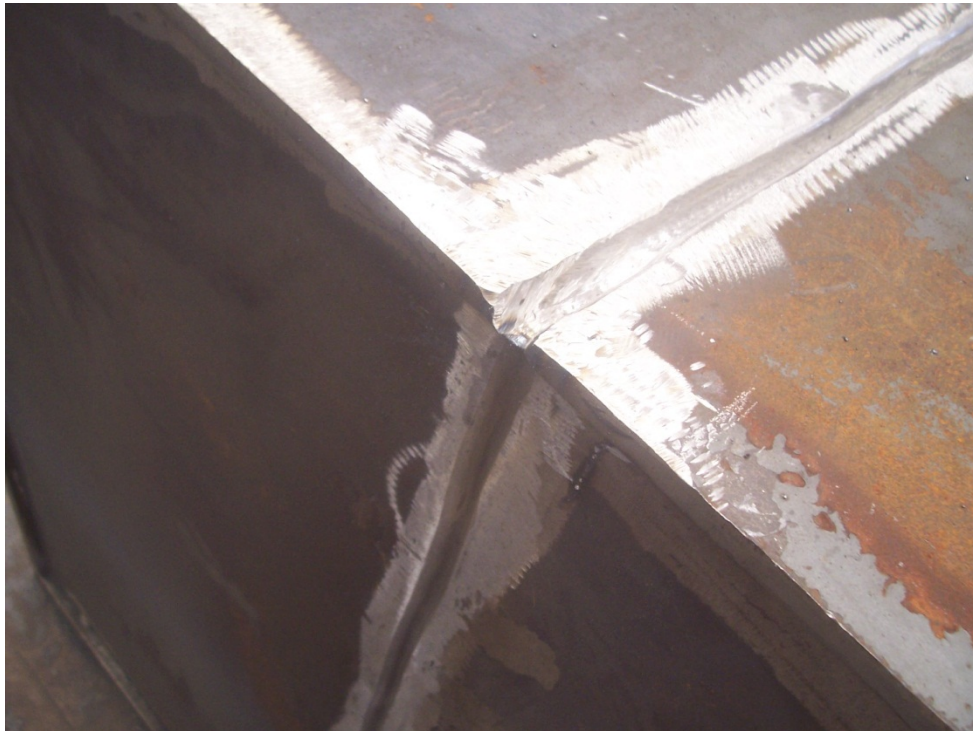
Figura 40 Junta de topo chanfrada pronta para soldagem
