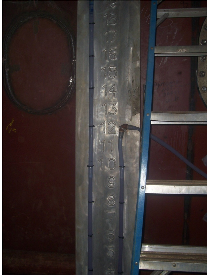
Figura 15 Coluna diferencial de água utilizada nos testes pneumáticos e hidrostáticos
