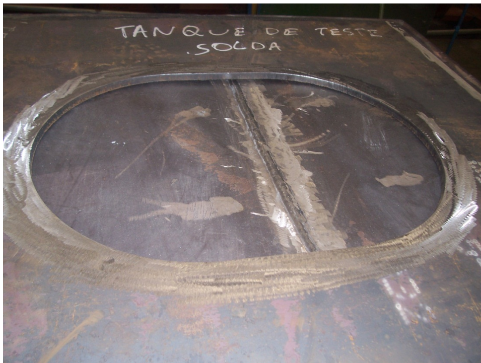
Figura 54 Preparação da junta anterior à montagem da porta de visita
