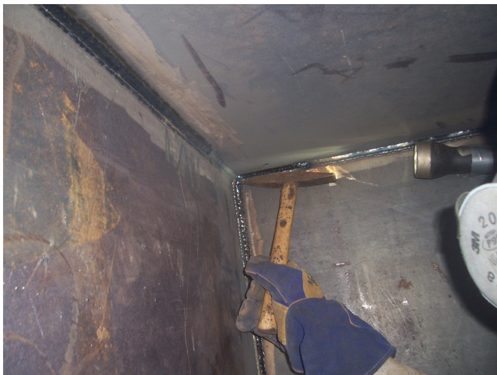
Figura 52 Remoção da escória em locais de acesso restrito à lixadeira
