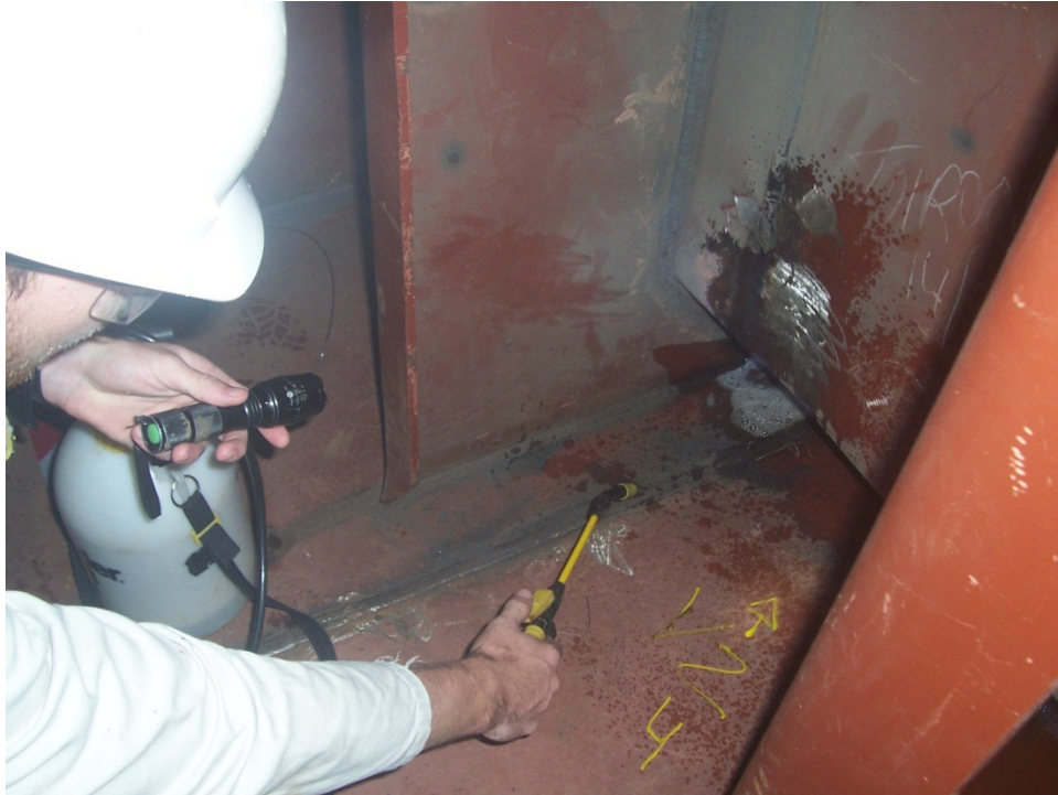
Figura 16 Pulverização de água e sabão nas soldas estanques durante um teste de pressão
