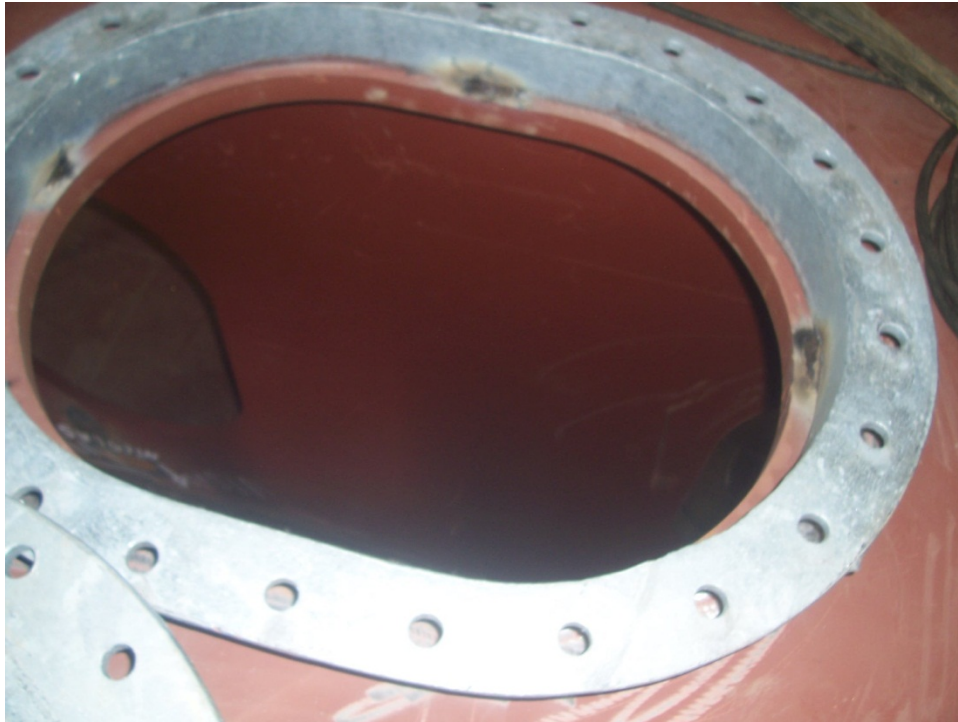
Figura 21 Porta de visita galvanizada montada
