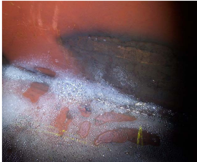
Figura 29 Vazamento durante um teste em junta de ângulo
