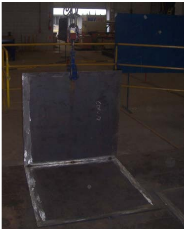
Figura 35 Montagem da peça com a junta preparada
