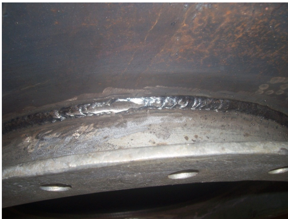
Figura 61 Acabamento e continuidade do cordão
