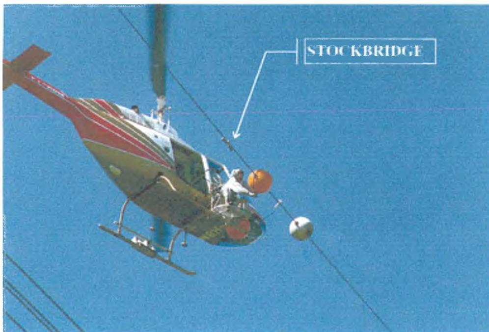
**FIGURA 79** - Montagem do stockbridge próximo a esfera na linha de transmissão.
