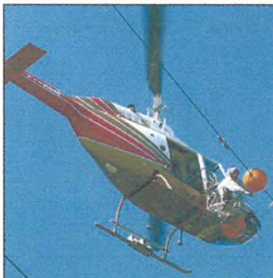
**FIGURA 46** - Montagem do stockbridge no vão entre as esferas com helicóptero.
