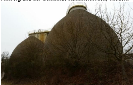
Figura 17 - Digestores anaeróbios de lodo de esgoto na forma de ovos – Estação de tratamento de esgotos Zweckverband zur Abwasserbeseitigung der Stadt Amberg und der Gemeinde Küssersbruck, Thuern - Alemanha.
