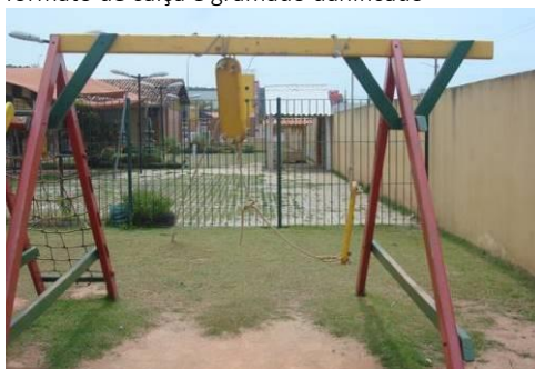
Figura 95 – Foto do parque infantil com brinquedo quebrado, ausência de balanço em formato de calça e gramado danificado
