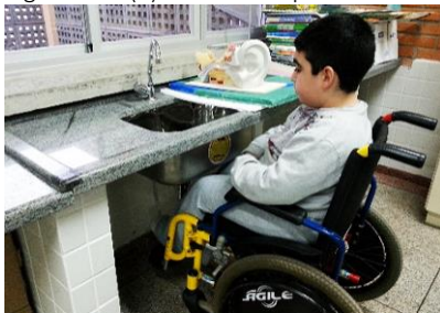
Figura 55 – (K) Bancada da pia inacessível
