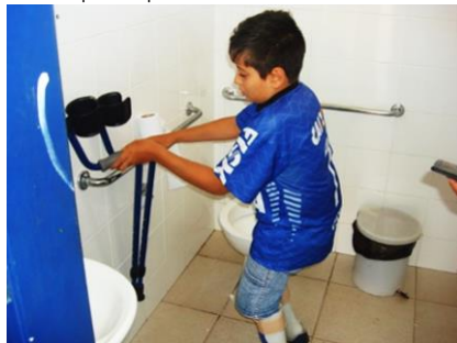
Figura 60 – (B) Aluno utilizando a barra lateral para apoiar muletas
