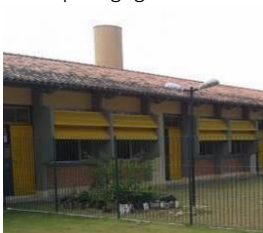
Figura 28 – Fachada bloco pedagógico
