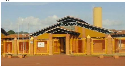
Figura 24 – Foto da entrada da escola
