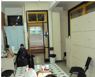
Figura 87 – Divisória na sala de professores bloqueada por armários
