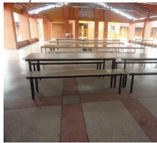
Figura 39 – Refeitório sem vedação
