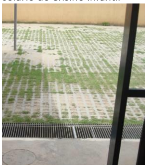
Figura 94 – Detalhe do piso concregrama e grelha no solarío do ensino infantil
