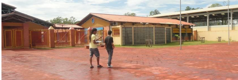
Figura 70 – (Foto A) LAI passando por cima do piso podotátil sem perceber a textura
