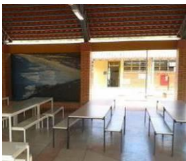
Figura 27 – Vedação em lona no refeitório
