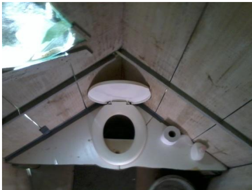
Figura 31. Área interna do BSVS com vaso sanitário segregador ao centro.
