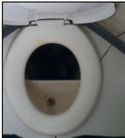
Figura 28 Vaso sanitário segregador utilizado no experimento em escala real.
