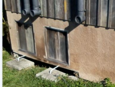
Figura 25 Recipiente fixo do tipo câmara para o armazenamento de fezes em BSC. Destaque para o dreno que evita o excesso de umidade na câmara.
