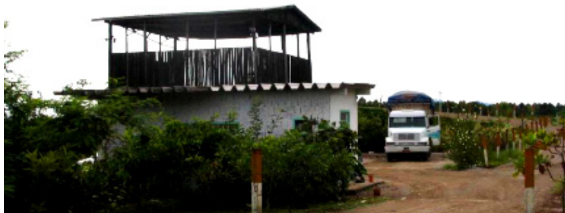
Figura 48. Estação de Transbordo da PROACTIVA.
