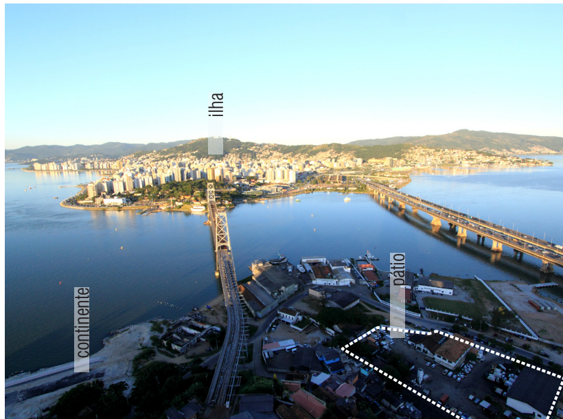
Figura 35. Pátio de estacionamento entre as pontes.
