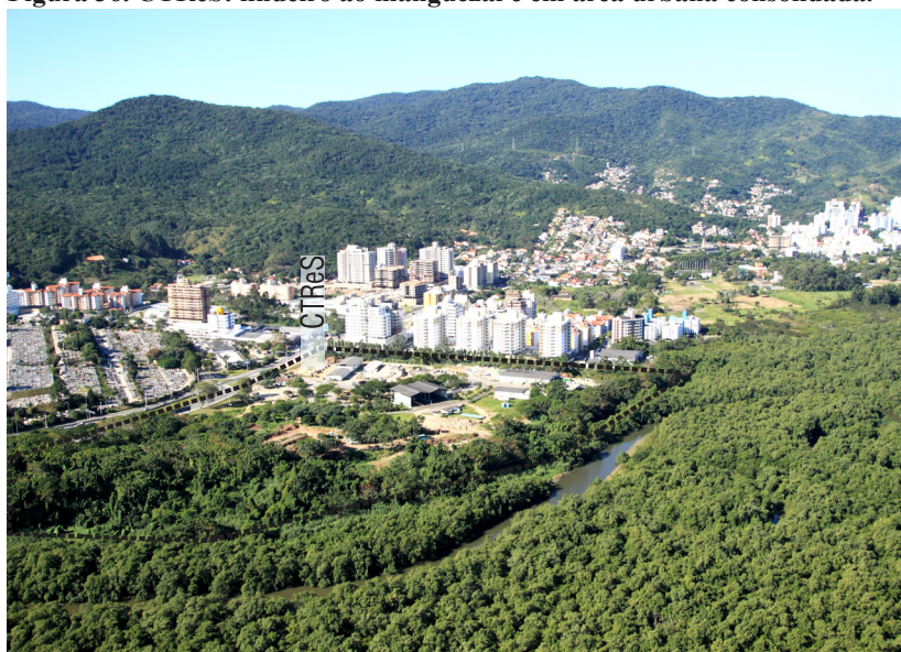
Figura 36. CTReS: lindeiro ao manguezal e em área urbana consolidada.
