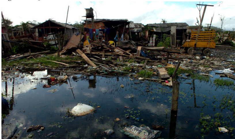
Figura 51. Quadro crítico de saneamento em Frei Damião.
