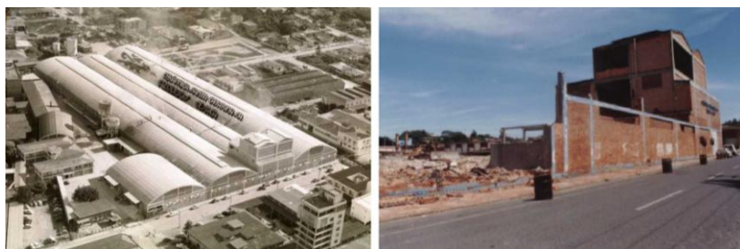
Figura 97- CESACA na década de 1970 e sua demolição em 2001
