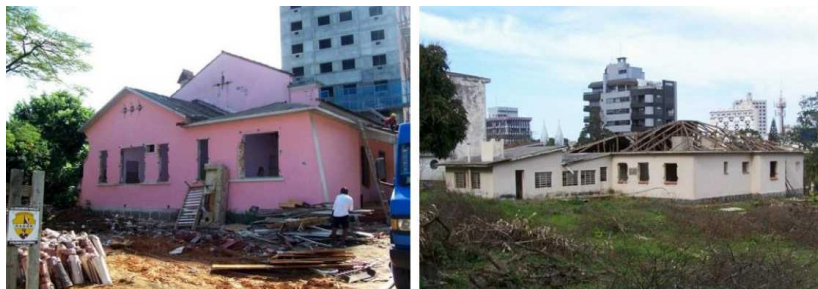
Figura 94 - Casas da primeira metade do século XX deram lugar a edifícios. A primeira, de propriedade do Eng. Sebastião Netos Campos, minerador da extinta CBCA
