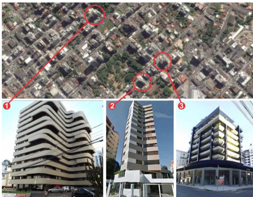
Figura 78 - Edifícios dos anos 1980 nas proximidades da Praça do Congresso.
