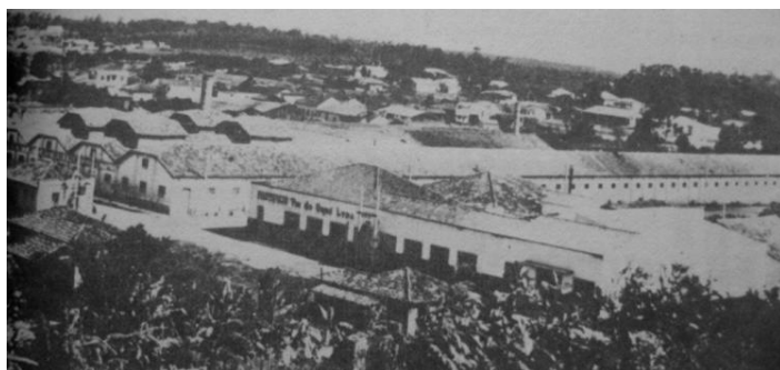
Figura 37 - Pastifício Fio de Ouro em primeiro plano e a CESACA (edificação maior ao fundo) entre os anos 1940 e 1950
