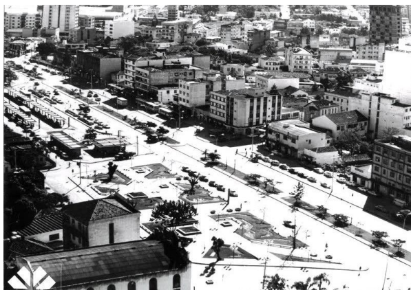
Figura 64 - Largo central da Avenida Centenário em 1980.
