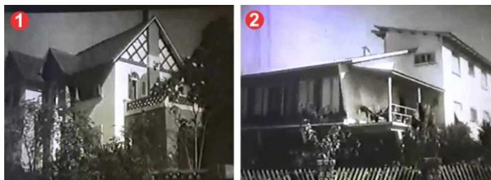
Figura 36 - Residências no entorno da Praça do Congresso.
