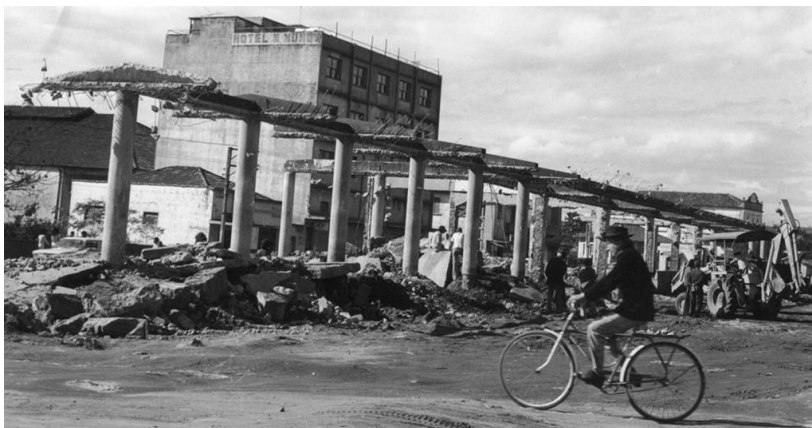
Figura 56 - Demolição da Estação de Passageiros em 1975.
