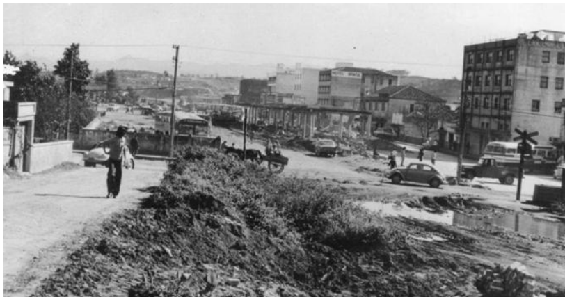
Figura 55 - Remoção dos trilhos e demolição da estação, em 1975.
