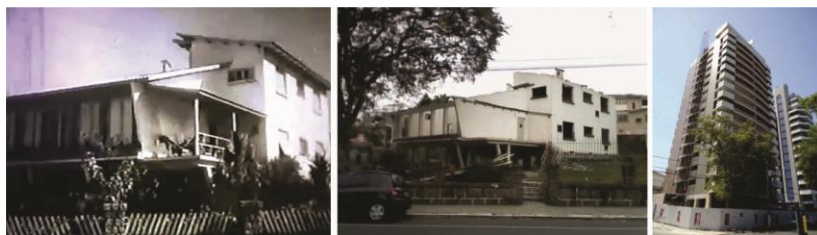
Figura 95 - A casa modernista com pilares em “V” em 1960, sua demolição em 2008, e as obras do novo edifício em 2014.
