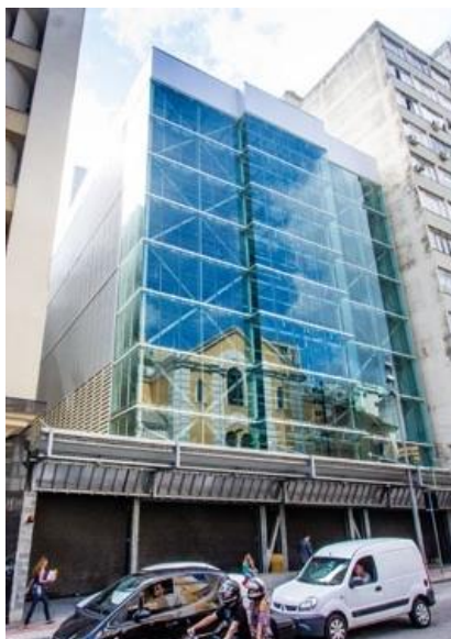
Figura 6: Com oito andares e área de 1300m 2 , o edifício está em construção desde 2010 e tem visual bastante contemporâneo, em estrutura metálica aparente e fachada envidraçada. Projetado para ser um edifício-garagem, conta com sistema de plataformas robotizadas, pioneiro em Florianópolis. Mesmo tendo mais 95% da obra já concluída, não há previsão para o início de seu funcionamento, em função de embargos sofridos nesse período.
