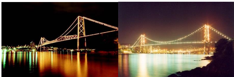
Figura 105: A iluminação artificial antiga e a atual da Ponte Hercílio Luz.
