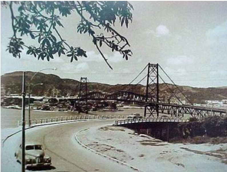
Figura 104: Ponte Hercílio Luz em 1960.
