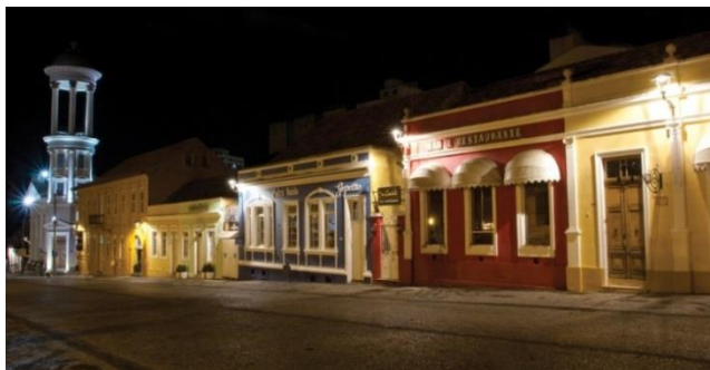
Figura 89: A iluminação artificial valorizou as fachadas históricas da região do Largo em Curitiba/PR, ressaltou texturas e cores e evidenciou volumes que marcam o conjunto.
