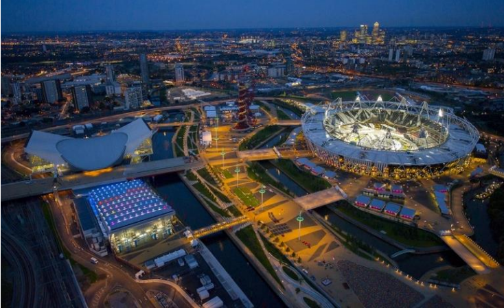
Figura 61: Imagem do mesmo setor da cidade de Londres, o qual define a qualidade da luz nos percursos do entorno, nas edificações e nos espaços públicos envolvidos no Parque Olímpico, na escala do pedestre.
