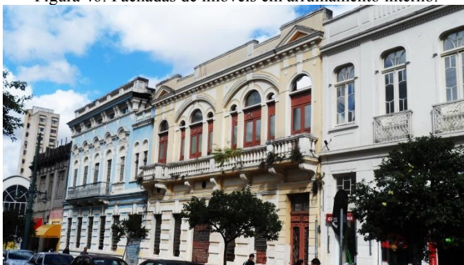
Figura 46: Fachadas de imóveis em arruinação interno.
