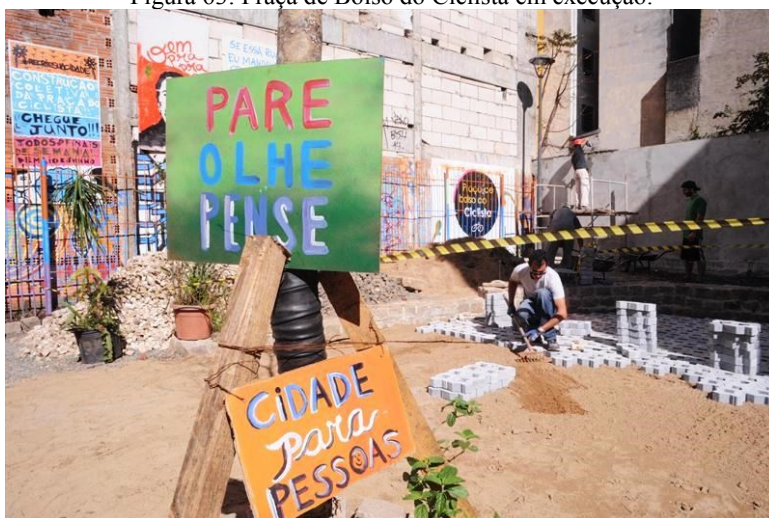
Figura 63: Praça de Bolso do Ciclista em execução.
