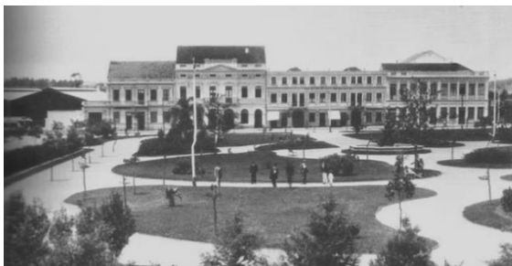
Figura 07: Praça Eufrásio Correia após a reforma, 1920.
