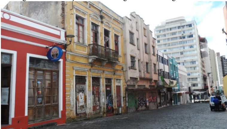
Figura 68: Edificações ociosas e degradadas no Largo da Ordem.
