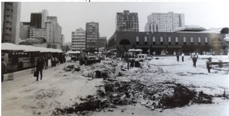
Figura 80: Obras de remodelação da praça; ao fundo, prédio da Rua da Cidadania.
