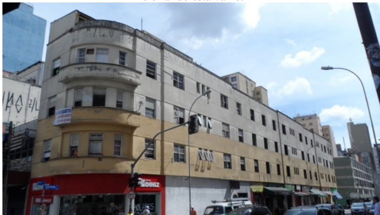
Figura 21: Imóvel subutilizado: a frente é utilizada como pensão e o fundo está vazio.
