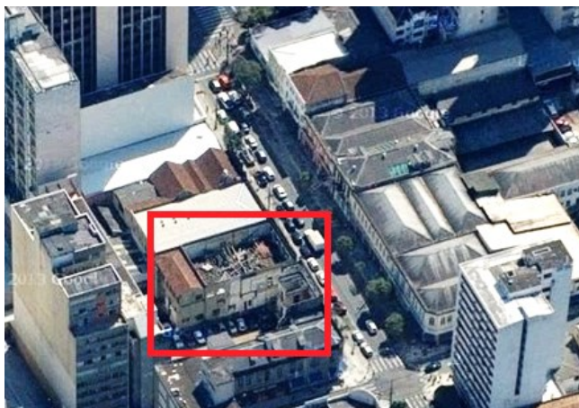
Figura 45: Imóveis em arruinação interno, Rua Barão do Rio Branco.
