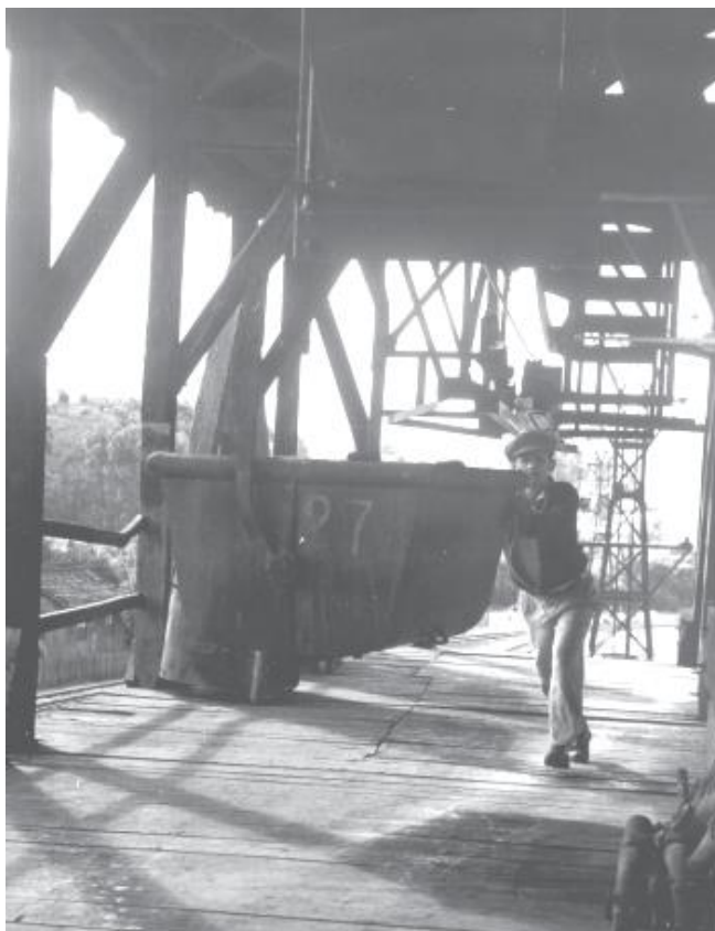
Figura 23 - Urussanga: local de distribuição dos vagonetes para o transporte do carvão, via cabo aéreo, entre as minas do Rio Deserto e Rio América (s.d.).
