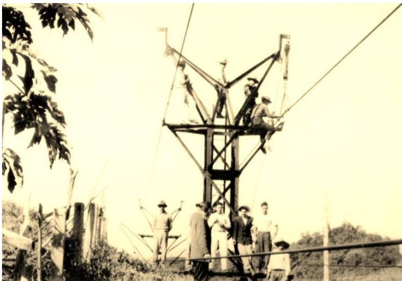
Figura 24 - Urussanga: montagem do teleférico que ligava o bairro Santana ao bairro Estação na década de 1950.
