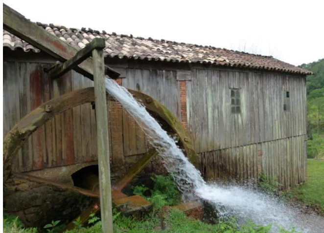
Figura 73 - Sítio Bez Fontana, edificação da marcenaria e sua roda d'água ainda em funcionamento.
