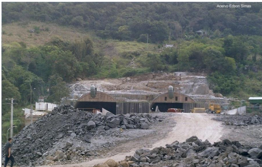
Figura 15 - Construção do túnel Antonieta de Barros - acervo Edson Simas
