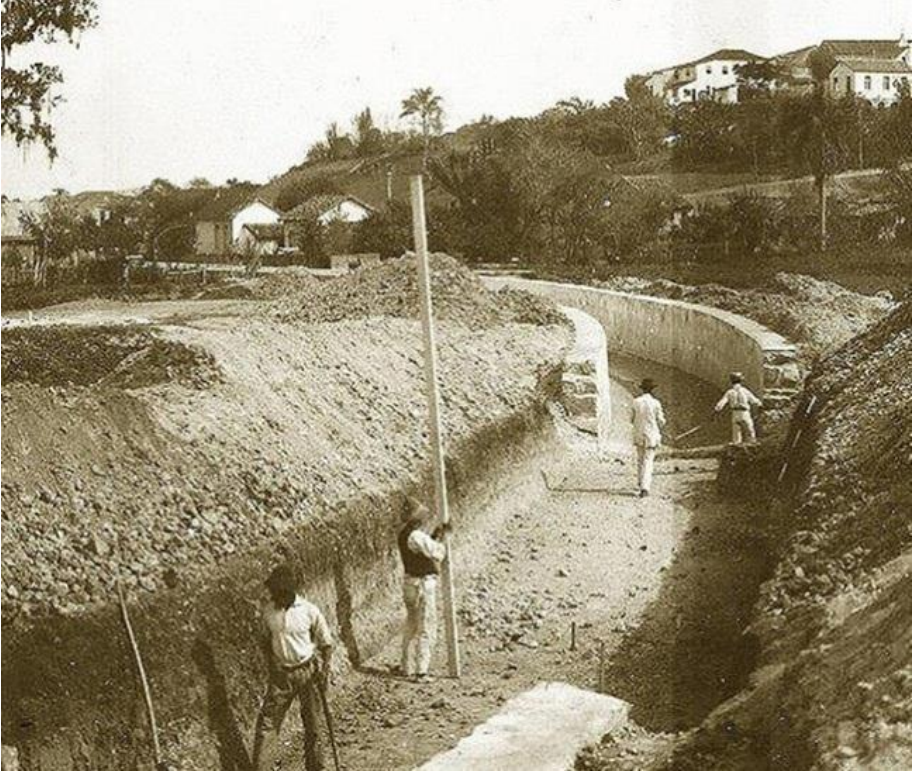
Figura 5 - Construção do canal no Rio da Bulha - década de 1920 - foto Betina Humeres da agência RBS
