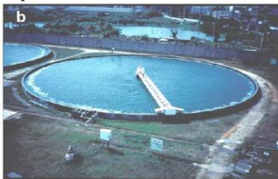
Figura 6 - Lagoa circular de agitador rotativo com cultivo de Chlorella em Taipei, Taiwan.
