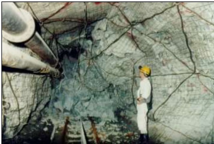
Figura 7 - Rockburst em um túnel de uma mina de ouro sul africana. Fonte: DURRHEIM, 2010.
