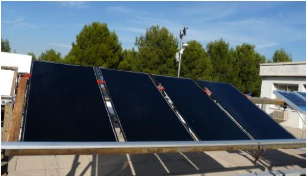
Figura 9 – Módulos de CdTe da empresa First Solar, modelo FR-272. Fonte: BÜHLER, 2011.
