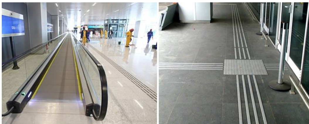
Figura 2 - Sinalização tátil no Aeroporto de Guarulhos
