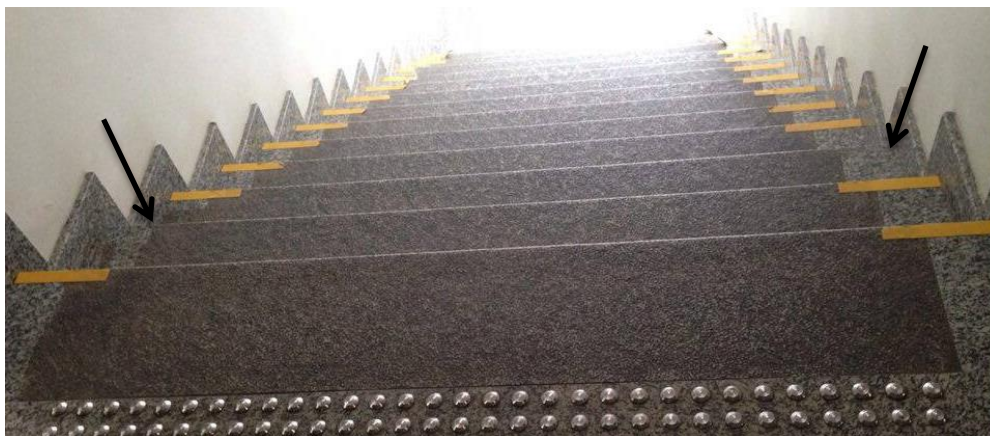
Figura 24 - Sinalização da escada principal
