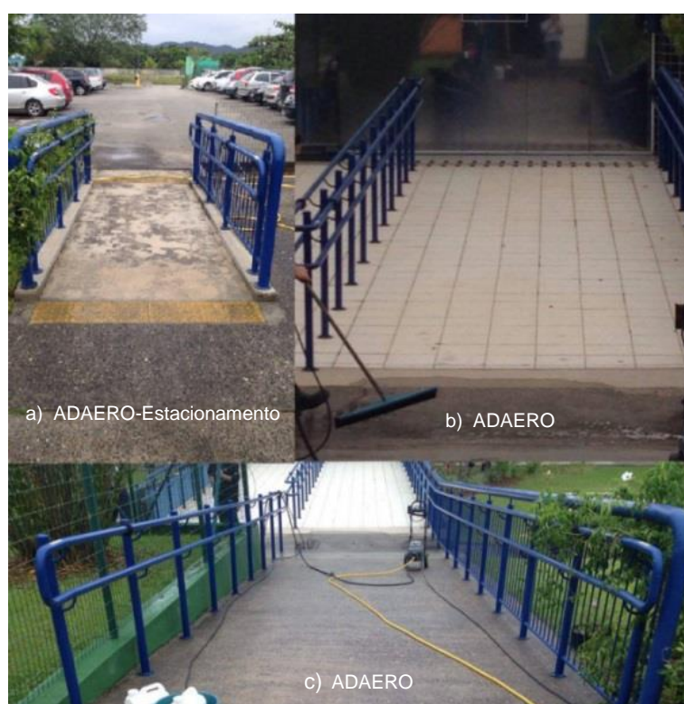
Figura 28 - Rampas de acesso ao ADAERO
