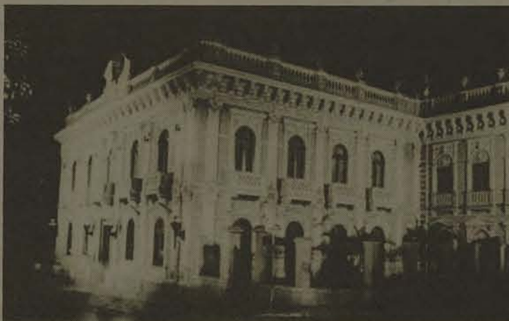
Palácio Cruz e Sousa um dos poucos prédios já restaurados
