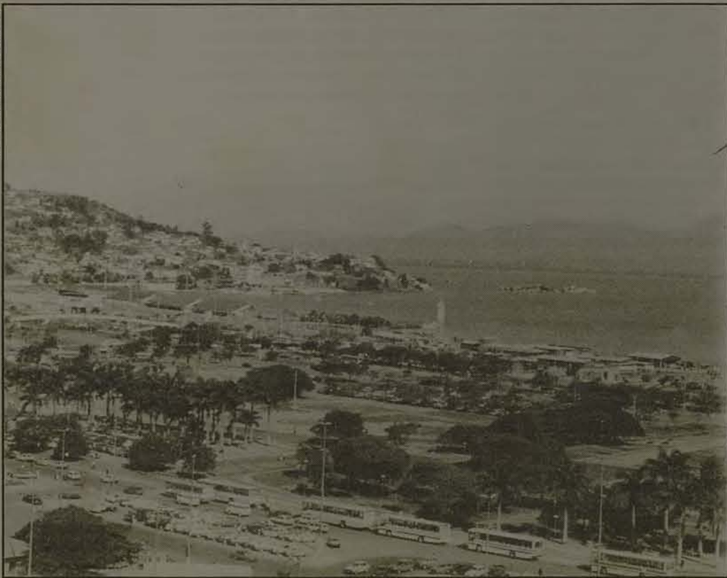
Via Expressa Sul vai desafogar o trânsito da região da Costeira
