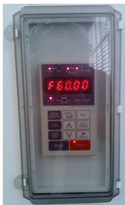
Figura 3.2: *Display* de controle do inversor modelo Varispeed E7 - Yaskawa
