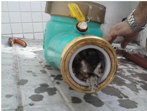
Figura 6 - Foto de Entupimento do filtro devido à presença de sólidos grosseiros na rede.
