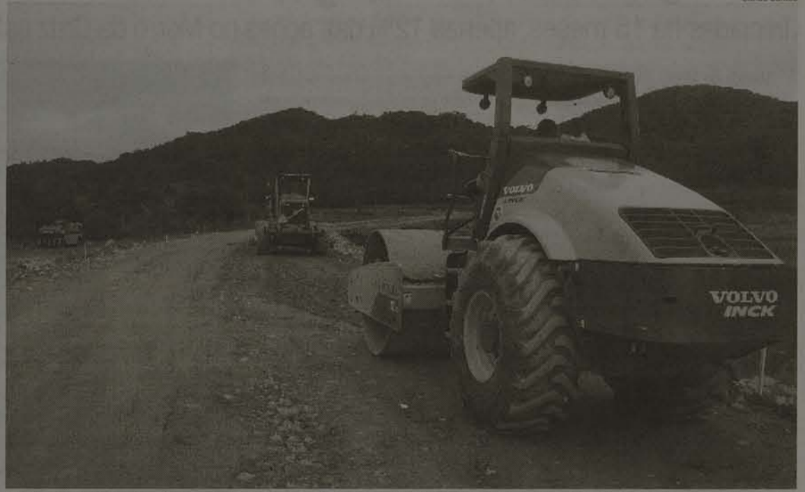
Desde o começo do ano, máquinas aceleram as obras de pavimentação da SC-407, que liga o município de Rancho Queimado a Anitápolis
