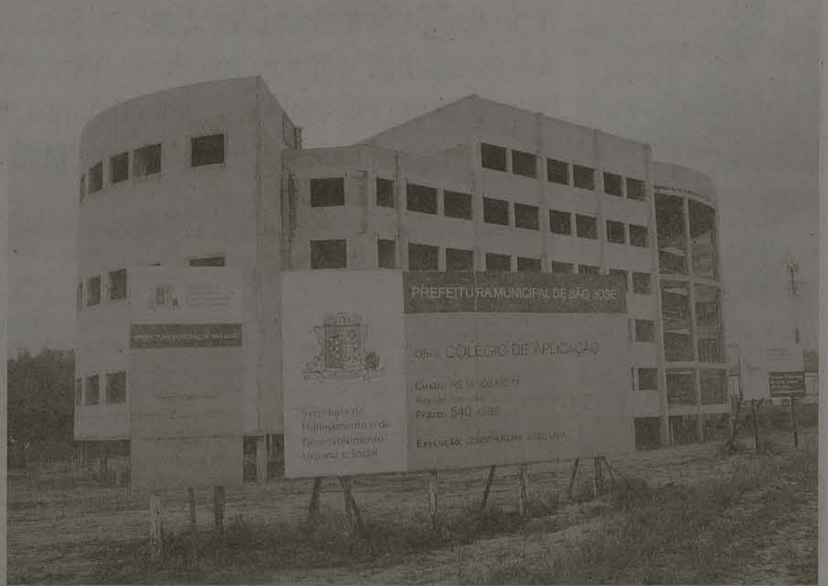
O Centro Universitário, em funcionamento há três anos, aguarda conclusão do prédio que abrigará a sede da instituição e o Colégio de Aplicação
