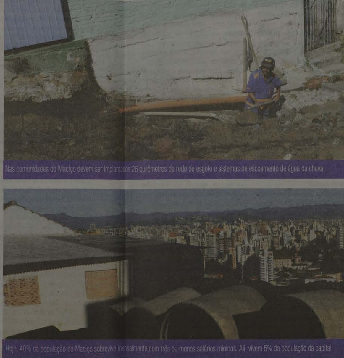
As obras de infraestrutura do Projeto do Maciço, que representam 53% do valor investido, apresentam um atraso de cerca de três meses - 35% das obras deveriam estar prontas
