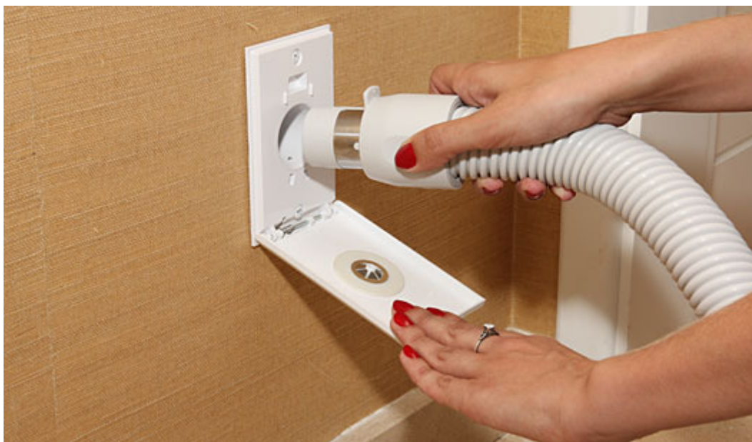
FIGURA 15 – Tomada de Aspiração Central
